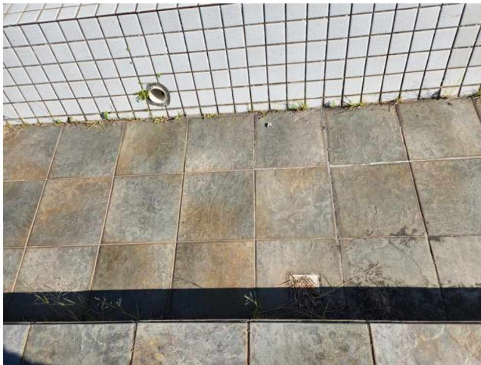
Imagem 7 – Ralo e gárgula na calha estrutural setor azul – Presença de vegetação e ausência dos rejuntas.
