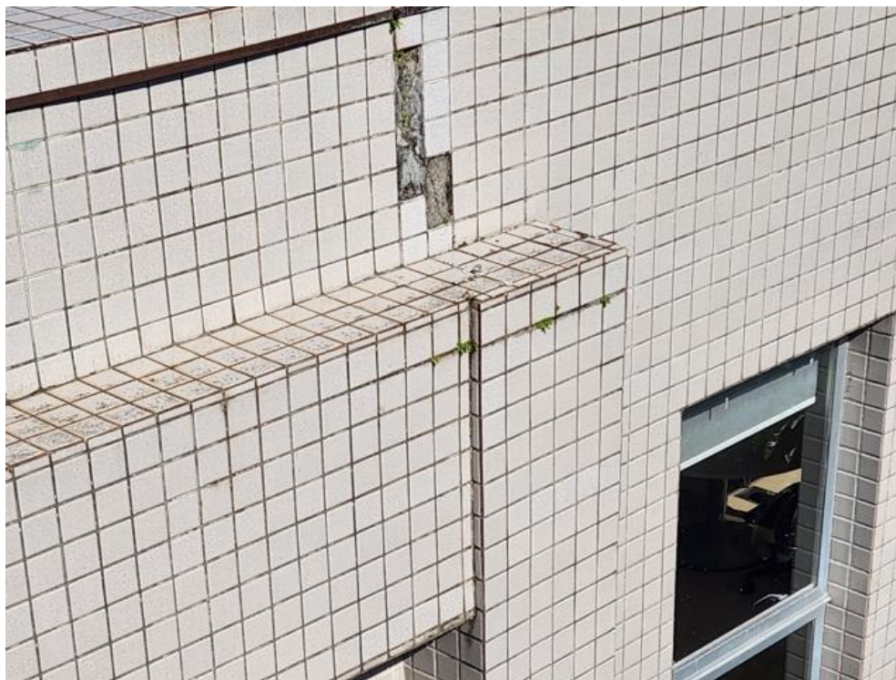
Imagem 29 – Ponto de acúmulo sem utilização de rufos, lacunas nas pastilhas e ausência dos rejuntas.
