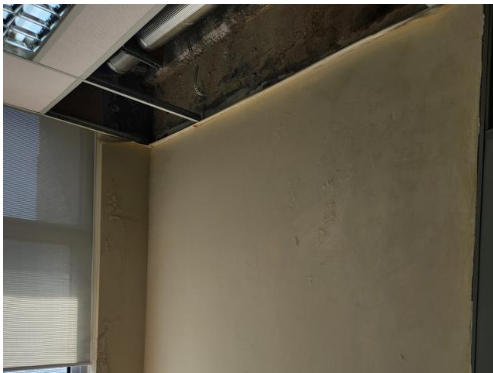
Imagem 71 - Infiltração atingindo o revestimento das paredes.
