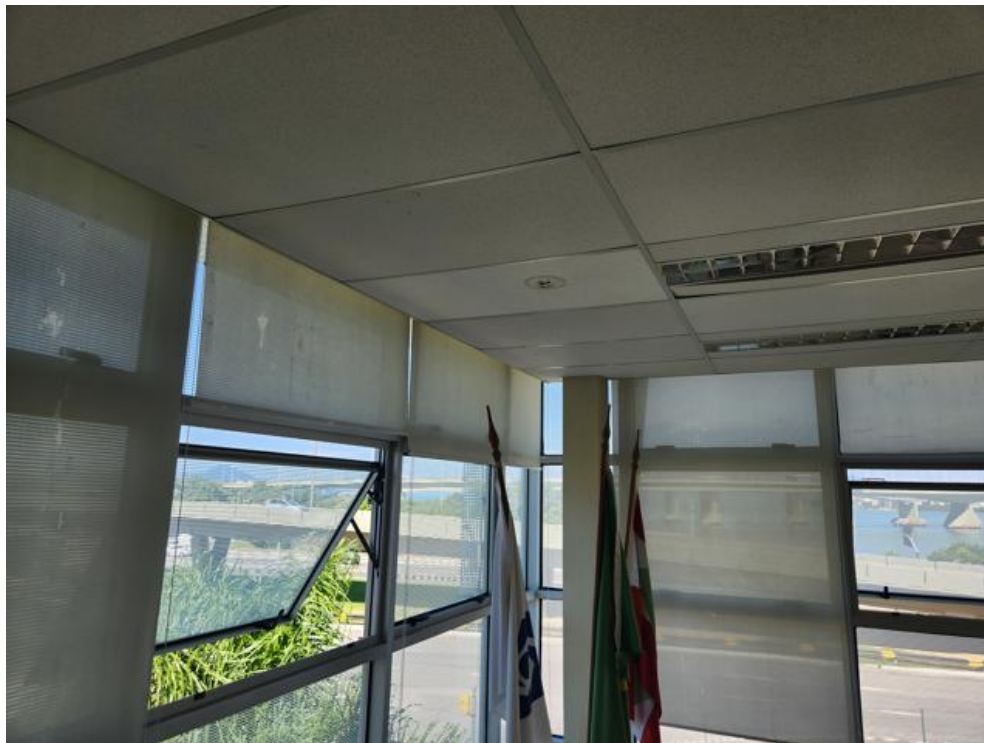
Imagem 82 – Persianas de controle solar com manchas de umidade.
