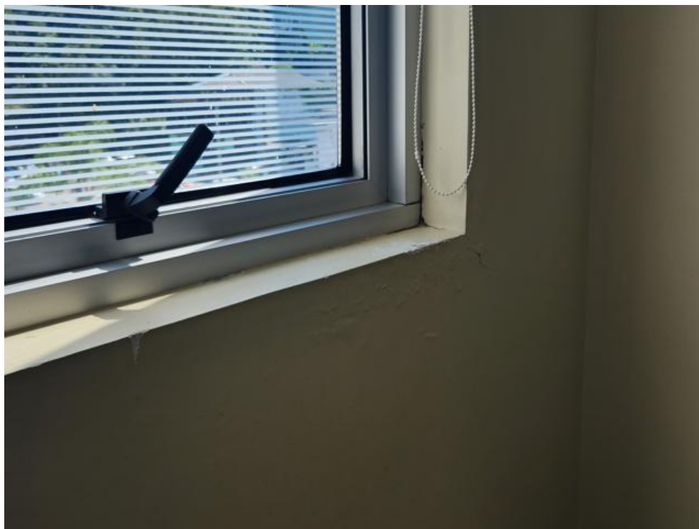
Imagem 101 - Marcas de danos no revestimento das paredes.
