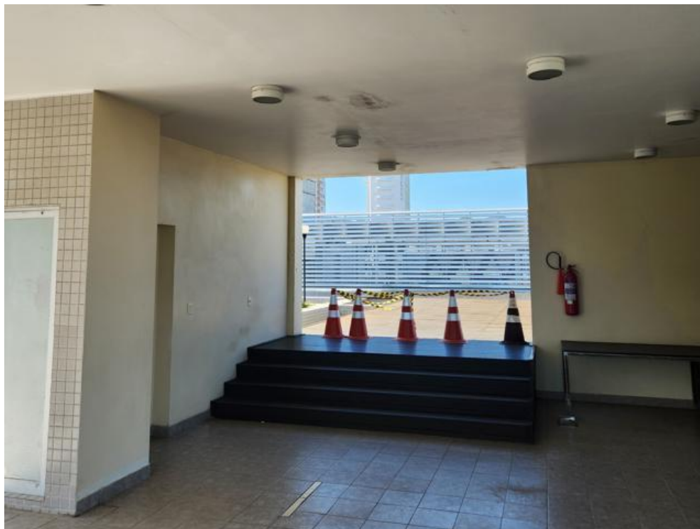
Imagem 62 – Marcas de infiltração na laje.
