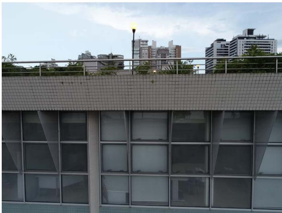
Imagem 220 - Fachada Nordeste – Presença de sujidade e vegetação, ausência de pingadeiras nas bordas e do rejunte branco.
