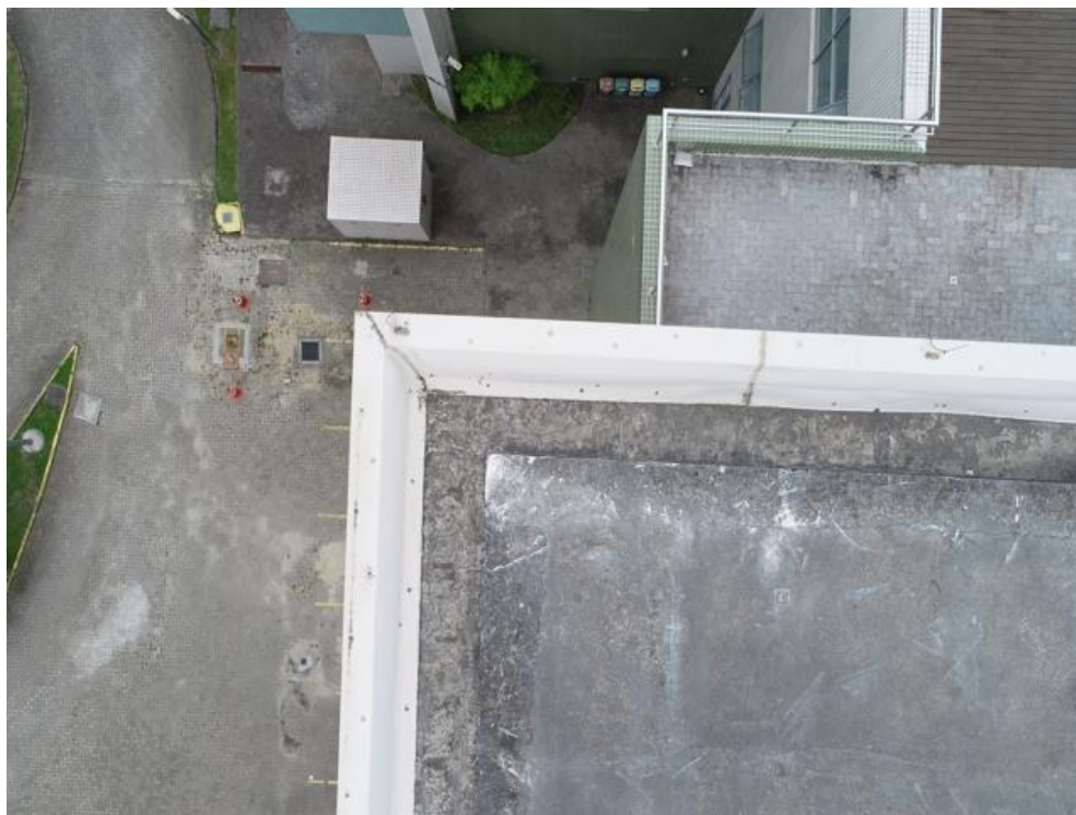
Imagem 115 - Presença de fissuras, rufo danificado, marcas de infiltração na proteção mecânica da laje.
