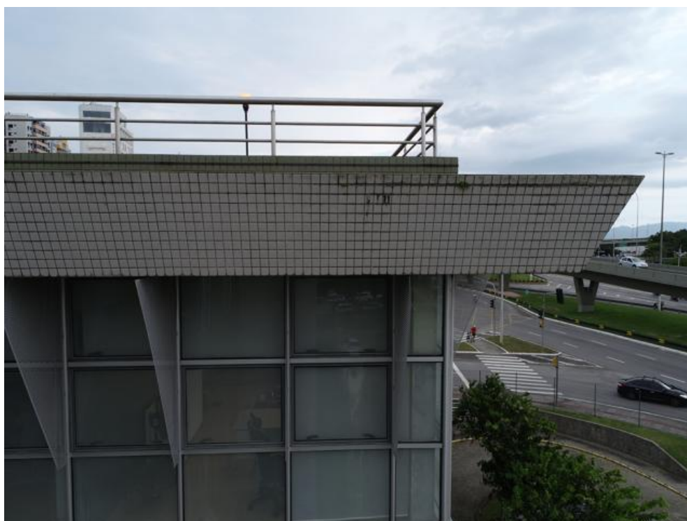
Imagem 233 - Presença de sujeira, vegetação, ausência de rejuntas e pingadeiras.
