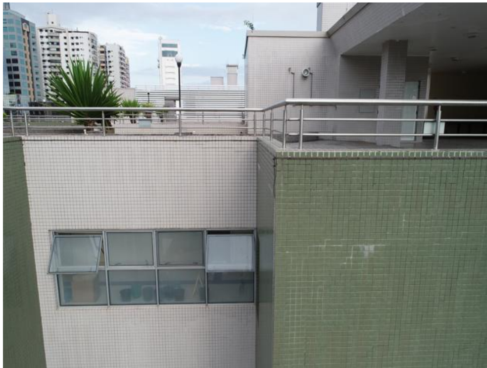
Imagem 184 - presença de sujeira, vegetação e ausência das pingadeiras e rejuntas, ponto localizado com indícios de carbonatação.
