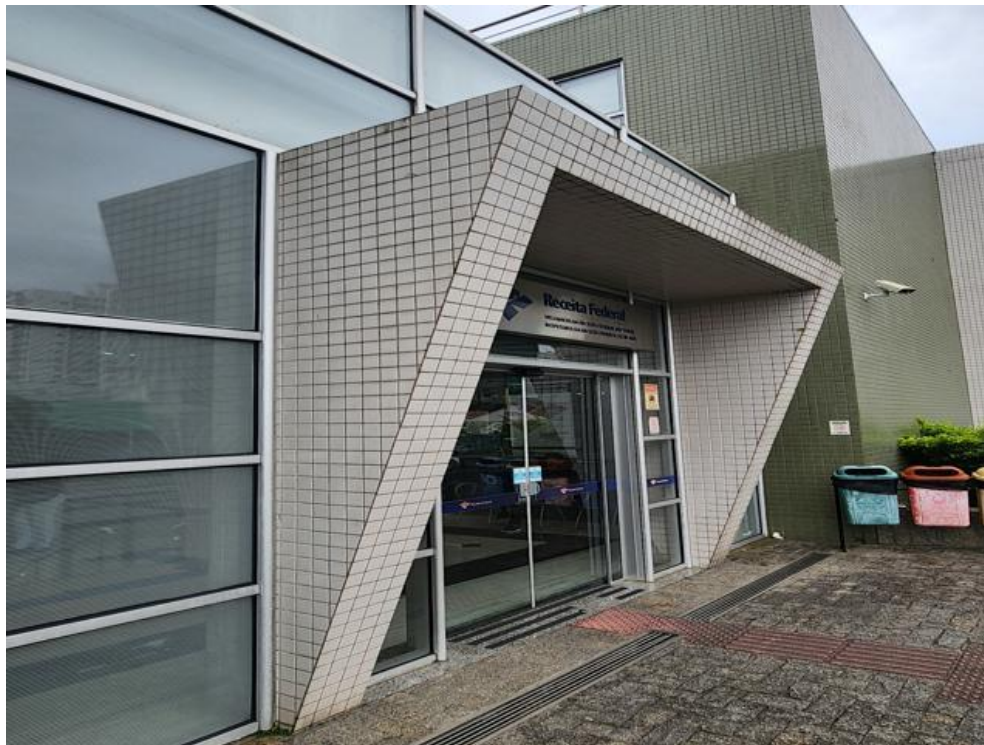
Imagem 144 – Pastilhas brancas e verdes com ausência praticamente total dos rejuntas, cobertura em pastilhas com ausência de pingadeiras.
