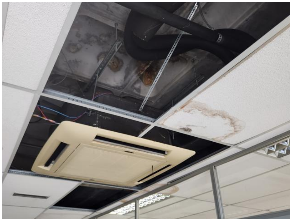
Imagem 89 – Marcas severas de infiltração na laje, danos nas placas de forro mineral, risco de danos em equipamentos.
