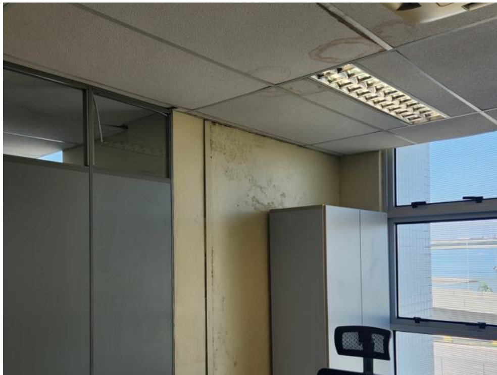
Imagem 78 – Marcas nas paredes de infiltração severa, placas de forro mineral danificadas.
