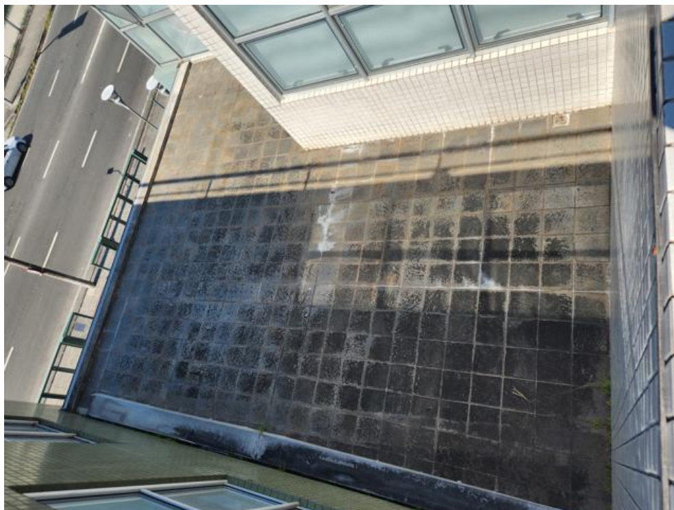
Imagem 55 – Laje sobre recepção – Marcas de carbonatação, sujeira e acúmulo de vegetação.
