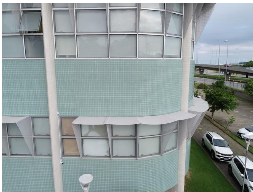
Imagem 209 – Presença de sujidade, pastilhas e rejunte na cor verde claro em bom estado.
