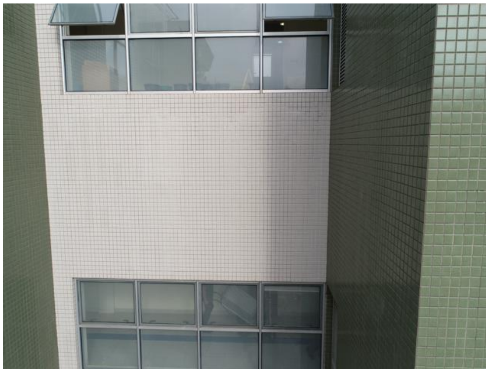
Imagem 187 - Presença de sujeira e ausência dos rejuntos.
