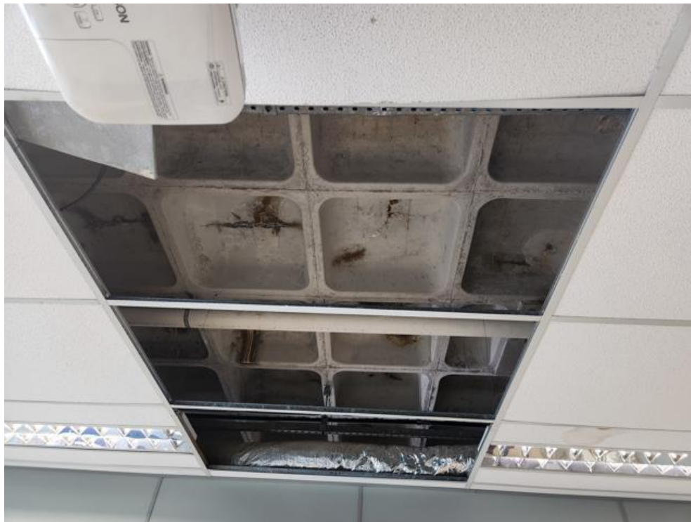
Imagem 84 – Marcas de infiltração severa.
