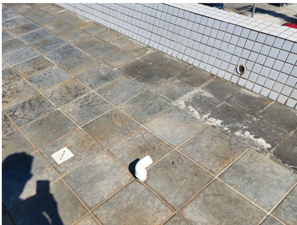
Imagem 37 – Tubo de ventilação e calha estrutural com manchas de carbonatação.
