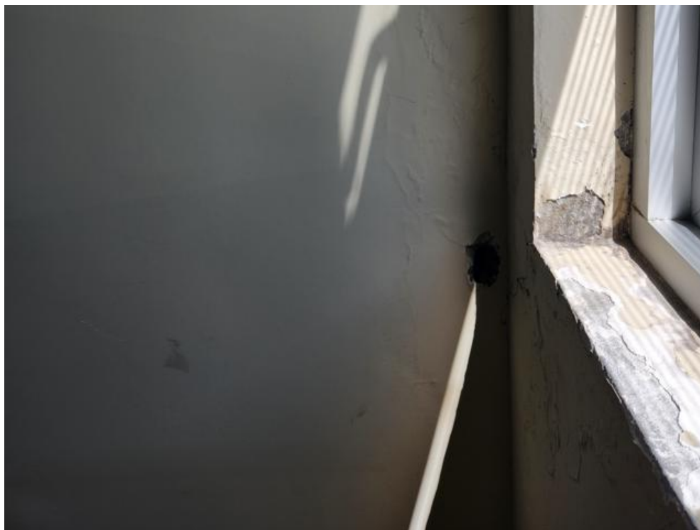
Imagem 99 - Marcas de danos no revestimento das paredes.
