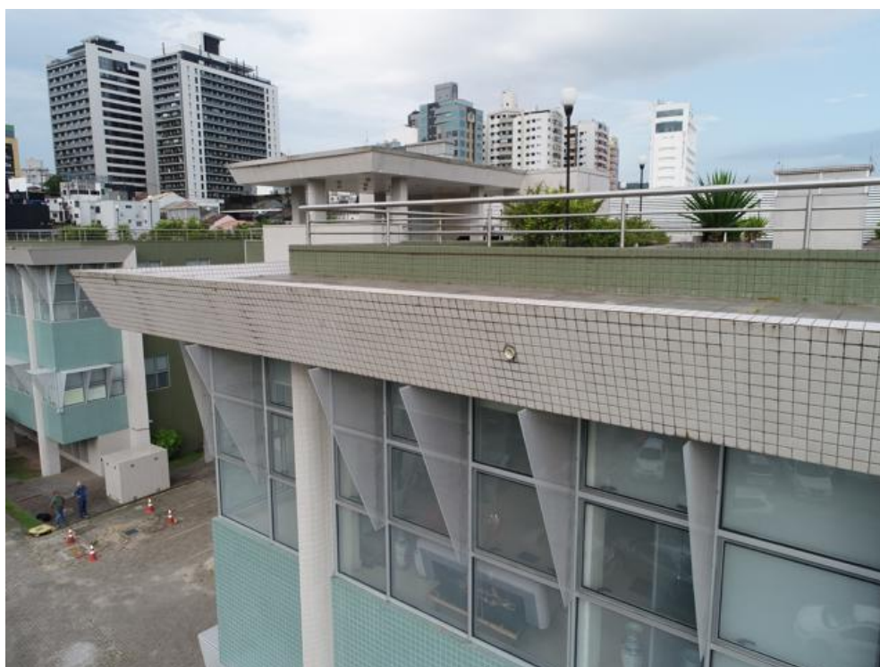
Imagem 207 - Sujeidade e ausência dos rejuntas. Presença de vegetação e ausência de pingadeiras.
