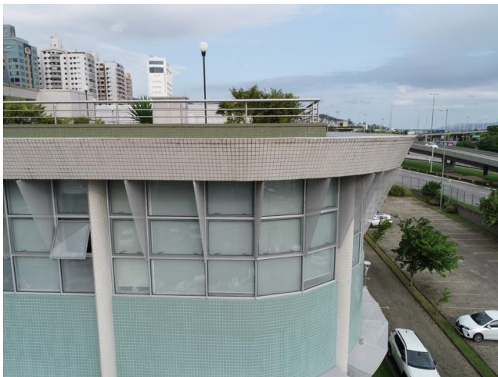
Imagem 208 - Sujidade e ausência dos rejunte. Presença de vegetação e ausência de pingadeiras.
