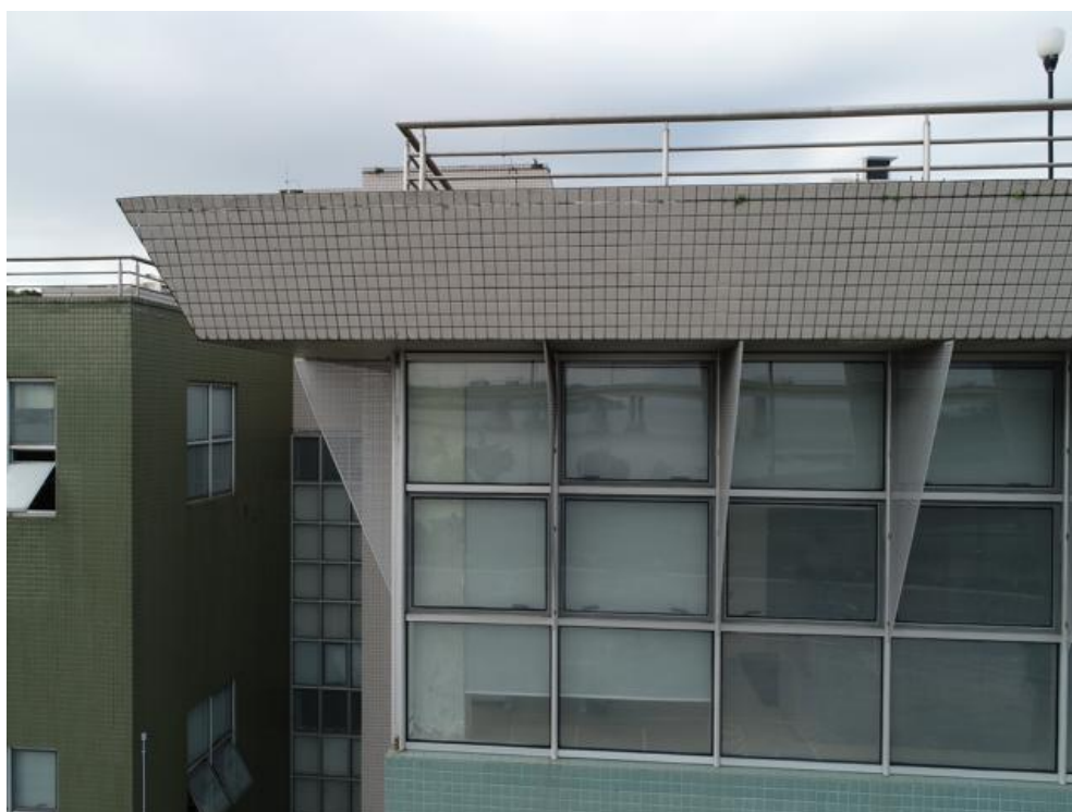
Imagem 237 - Presença de sujeira, vegetação, ausência de rejuntas e pingadeiras.
