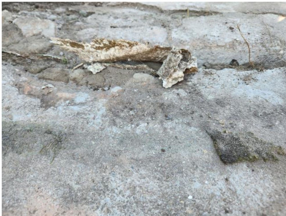
Imagem 4 – Detalhe da Junta de construção – Setor azul/ciano. Pedaço de EPS.
