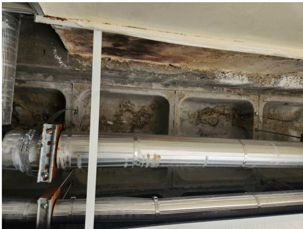
Imagem 69 – Infiltração severa na laje com sinais de carbonatação e oxidação das armaduras.
