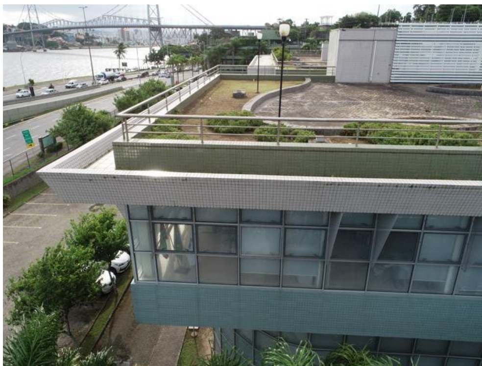
Imagem 163 - Pastilhas brancas sem rejunte e ausência de pingadeiras.
