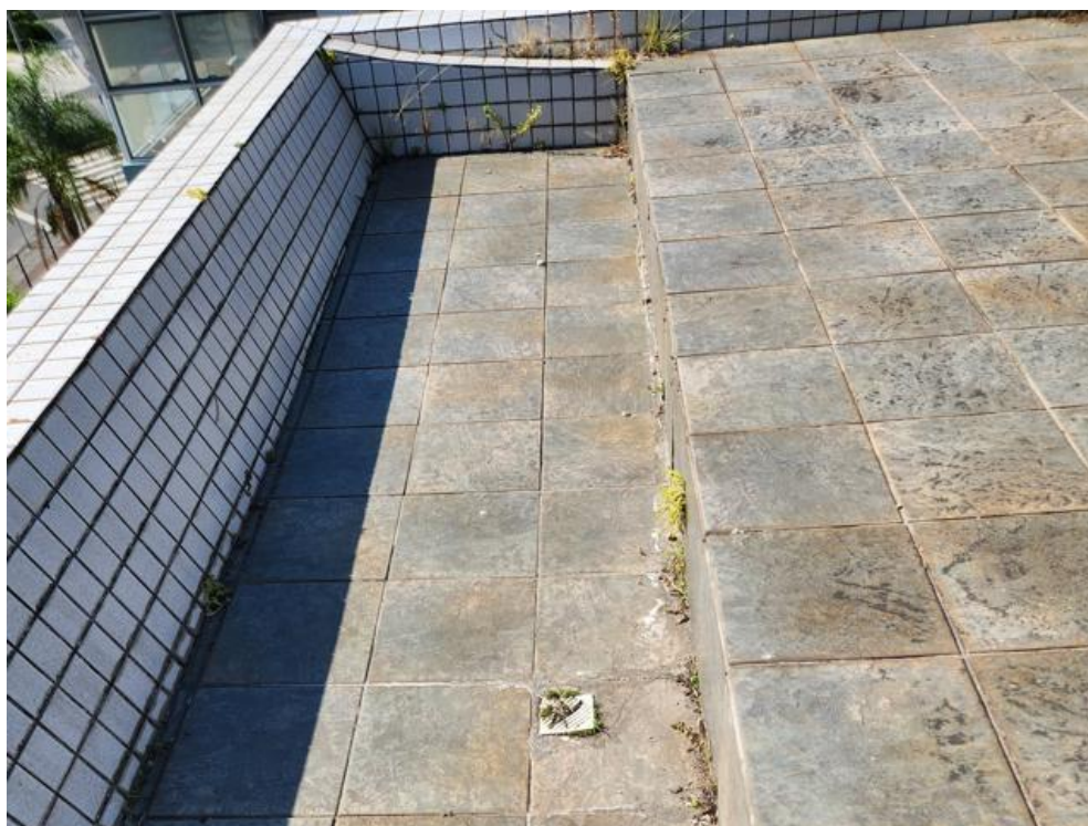
Imagem 35 – Calha estrutural – ralos com presença de vegetação e grelhas quebradas.
