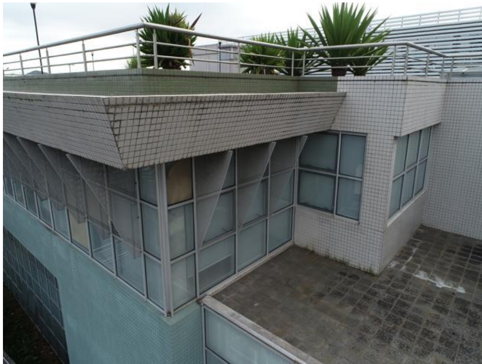
Imagem 156 – Presença de sujeira, ausência de pingadeiras e rejuntas.
