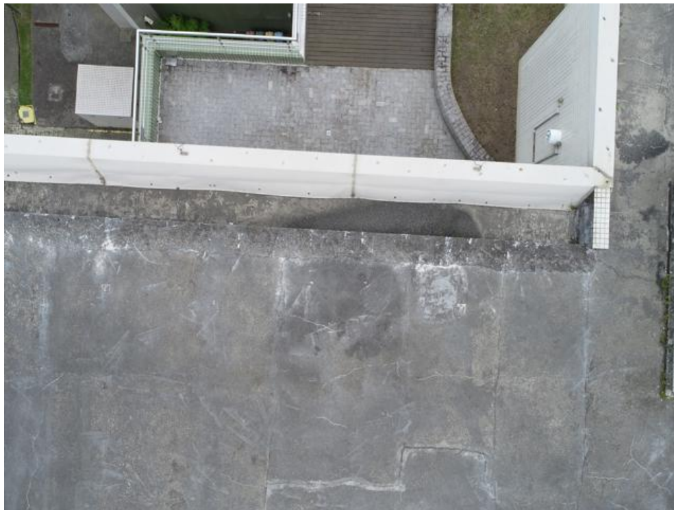
Imagem 114 – Acúmulo de umidade em calha estrutural, presença de vegetação.
