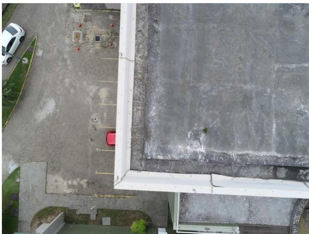
Imagem 111 – Laje da em área de acesso a cobertura - Presença de fissuras, rufo danificado, marcas de infiltração na proteção mecânica da laje do setor ciano.
