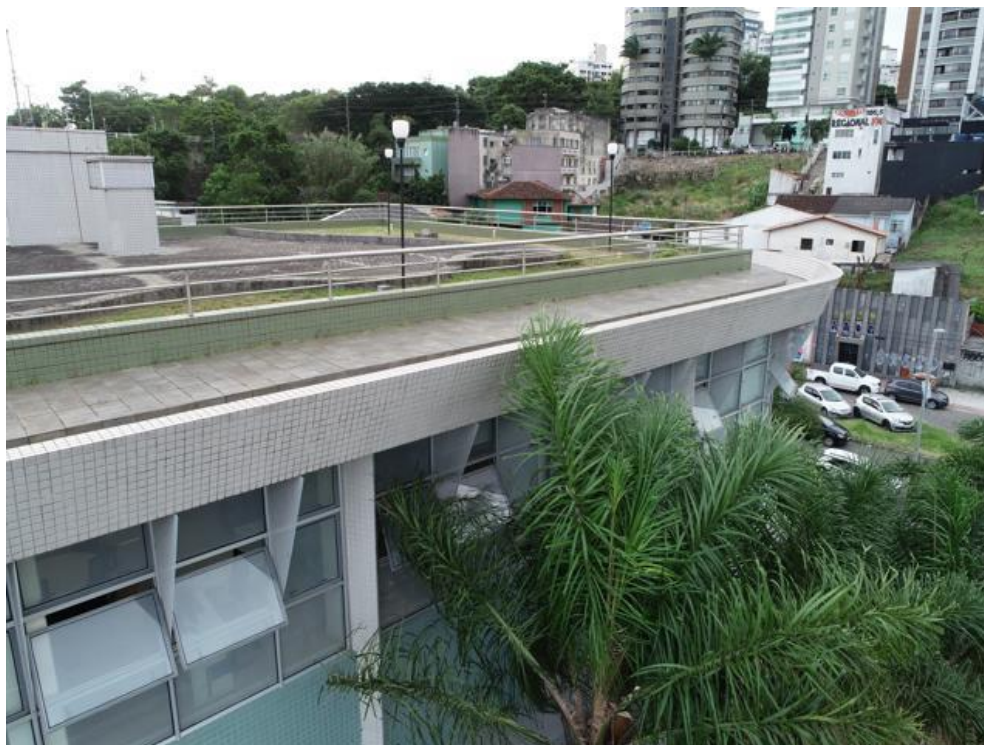
Imagem 151 - Ausência das pingadeiras, presença grande de sujidade e ausência dos rejuntos.
