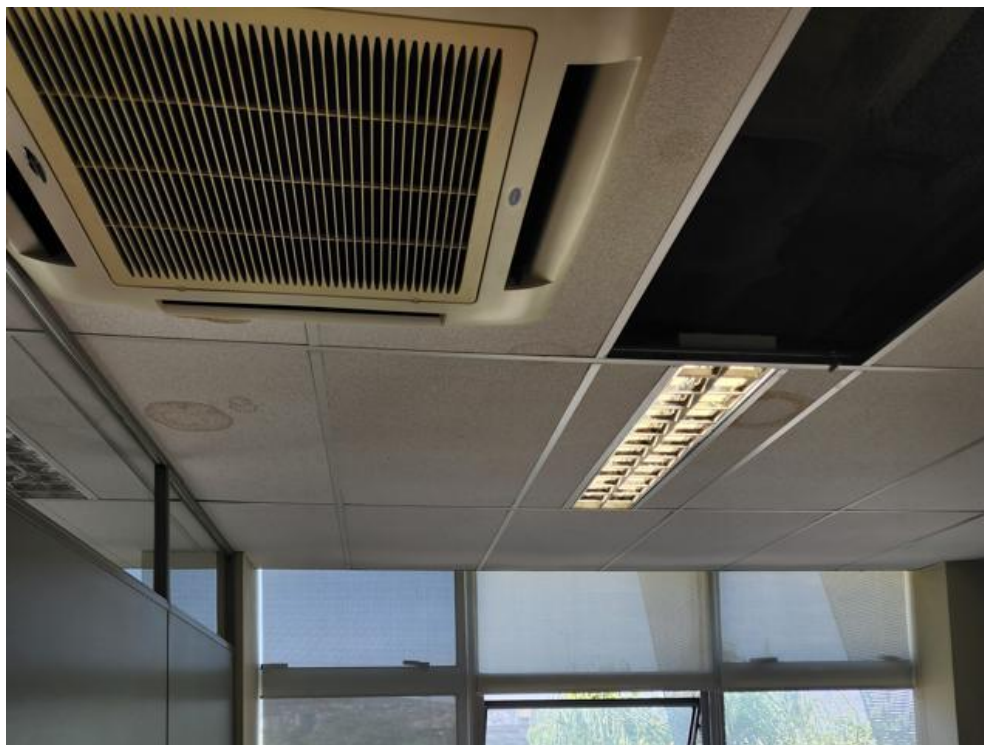
Imagem 86 – Marcas de infiltração nas placas de forro mineral.
