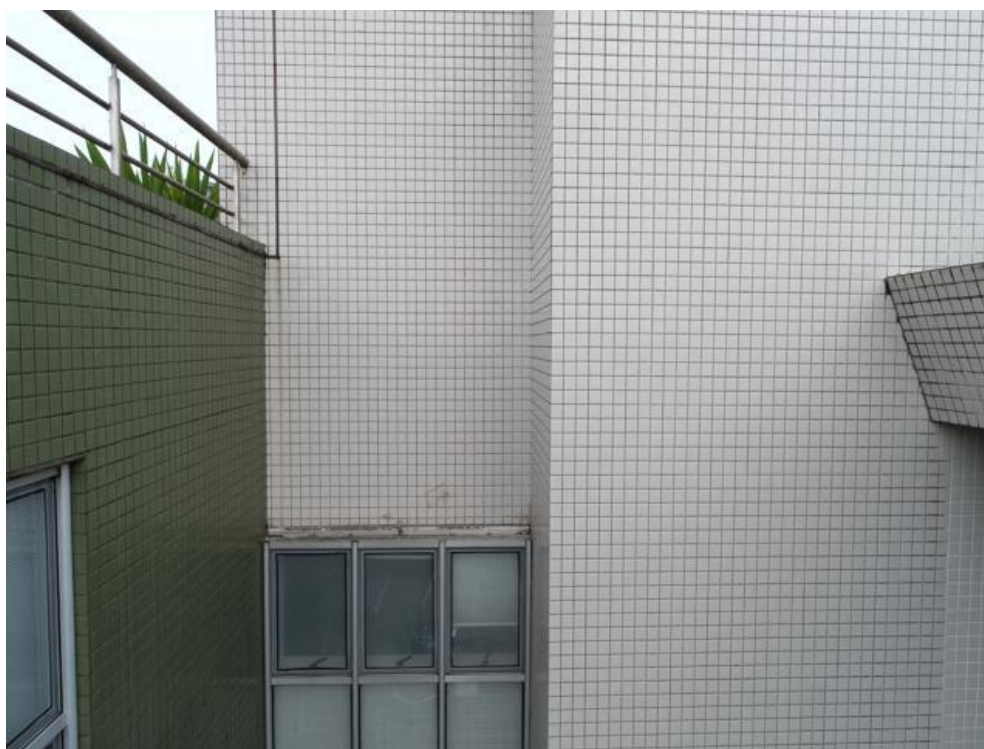
Imagem 231 – Presença de sujeira e ausência de rejunte.
