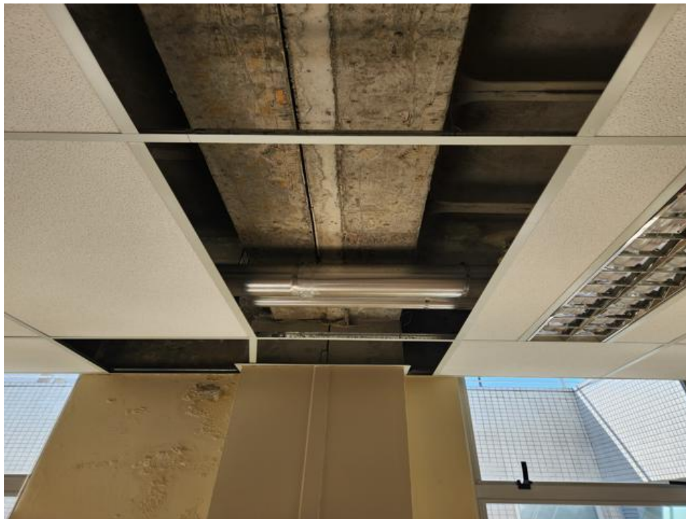
Imagem 106 – Marcas de infiltração nas paredes próxima a junta de construção.
