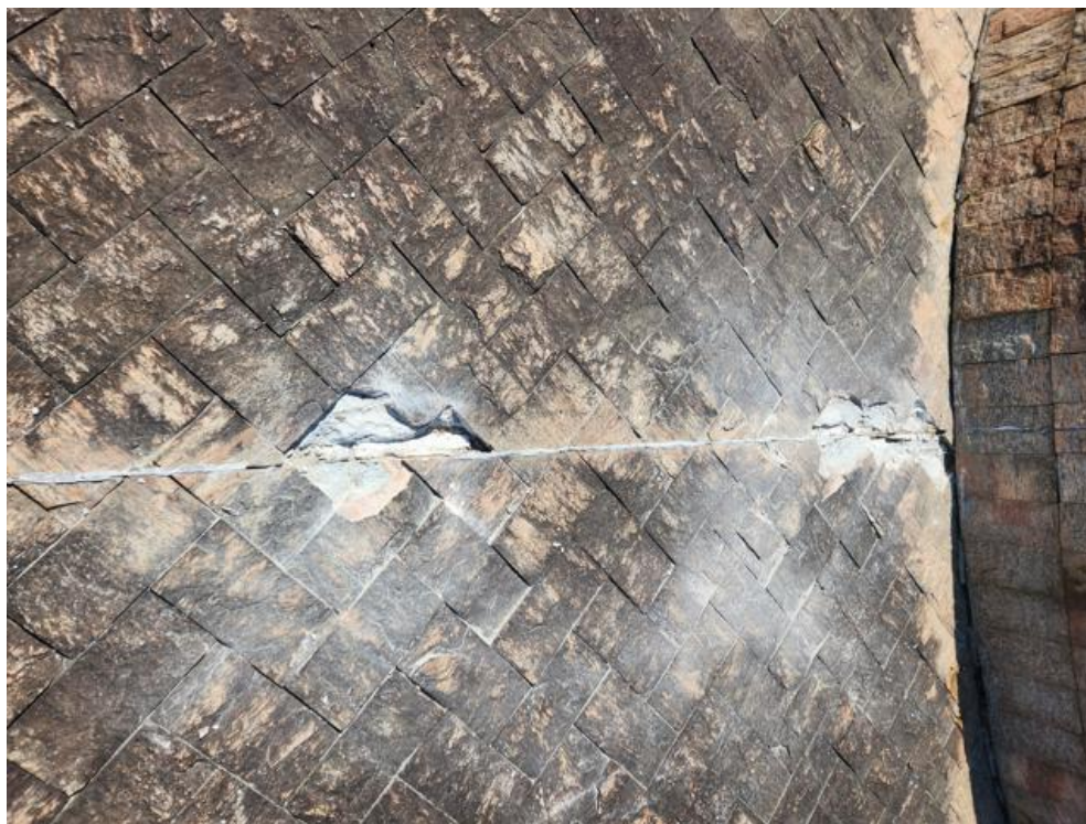
Imagem 59 – Junta de construção – Setor magenta/amarelo.
