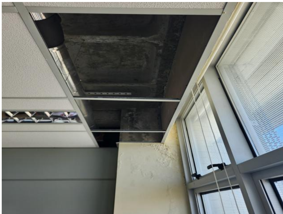
Imagem 109 - Marcas na laje e paredes de infiltração severa.
