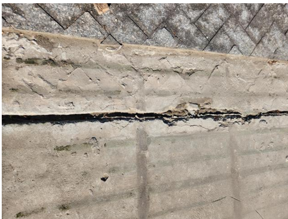
Imagem 5 – Junta de Construção – Setor azul/ciano.
