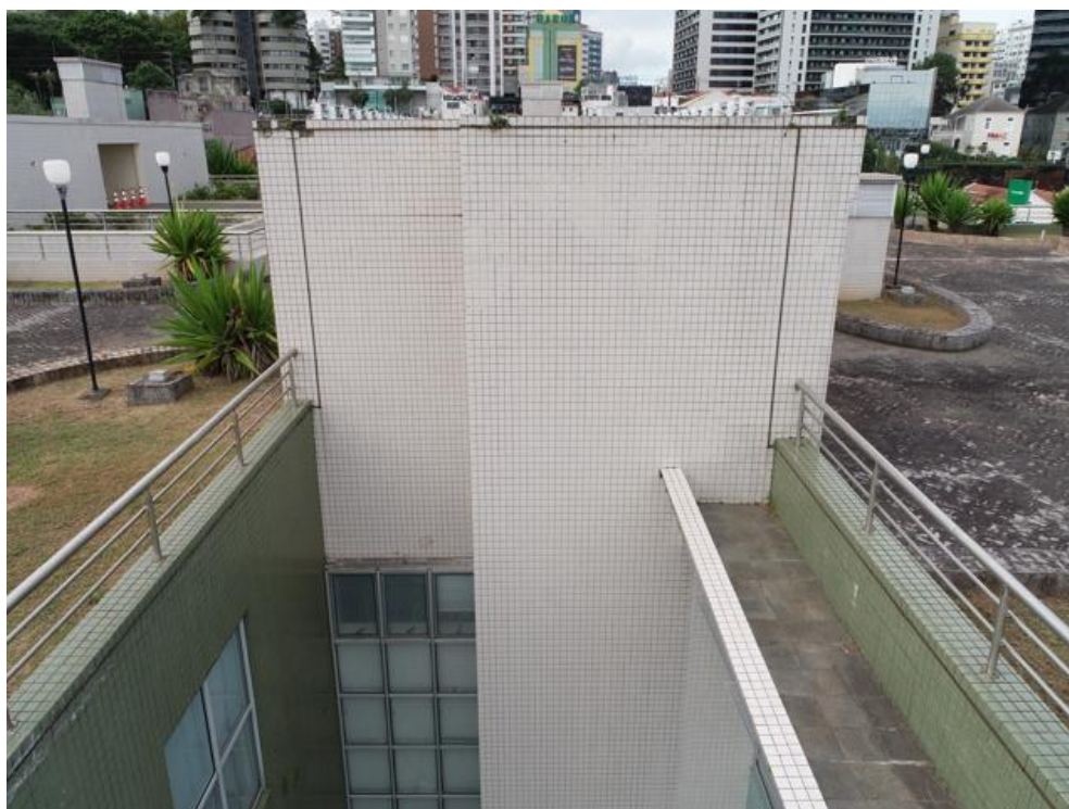
Imagem 213 – Fixação do SPDA, Presença de sujeira e ausência de pingadeiras e rejuntas
