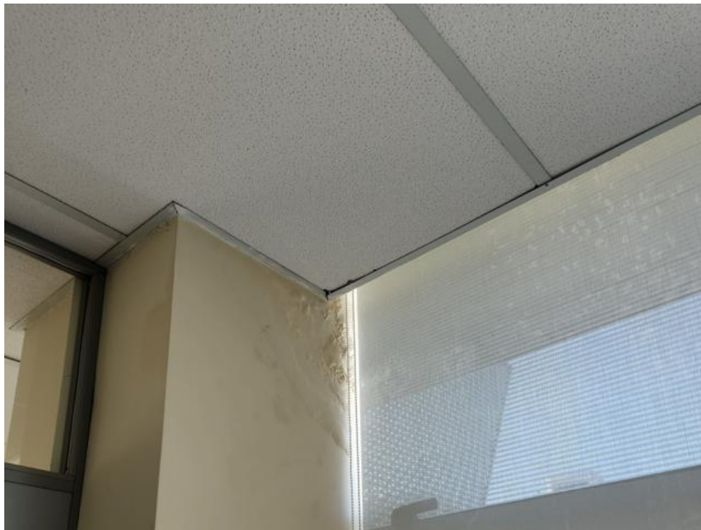
Imagem 92 – Marcas no revestimento das paredes, manchas nas persianas de controle solar.
