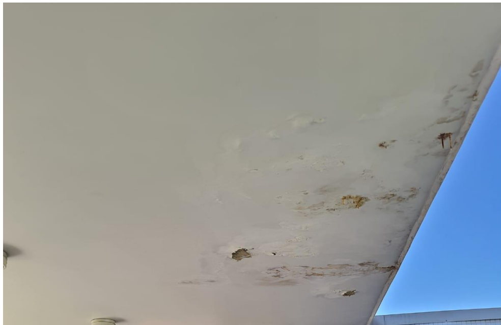
Imagem 30 – Processo de infiltração e carbonatação do concreto e corrosão das armaduras. – Setor ciano.
