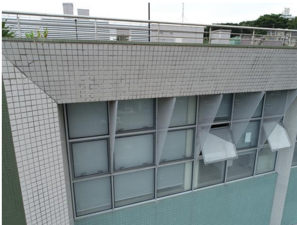
Imagem 149 – Ausência das pingadeiras, presença grande de sujeira e ausência dos rejuntas.
