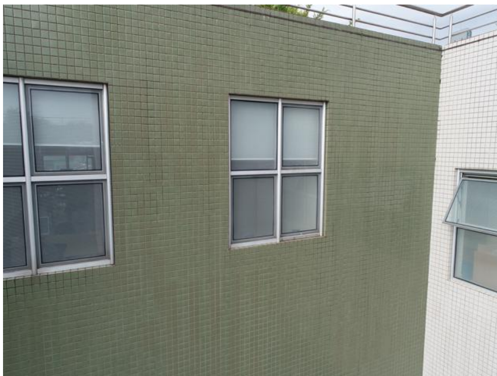
Imagem 185 – Presença de sujeira e ausência dos rejuntas
