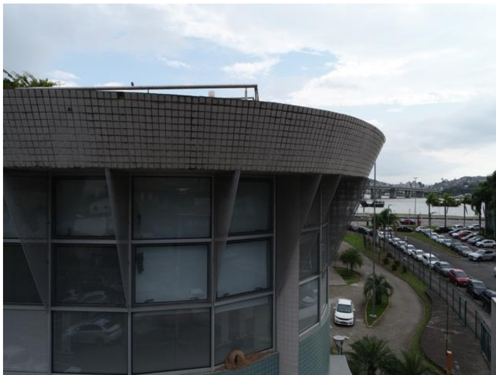
Imagem 176 – Lacunas nas pastilhas, presença de sujeira, ausência de pingadeiras e rejunte branco
