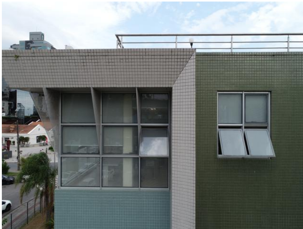
Imagem 166 – Presença de vegetação, sujeira e pastilhas sem rejunte.
