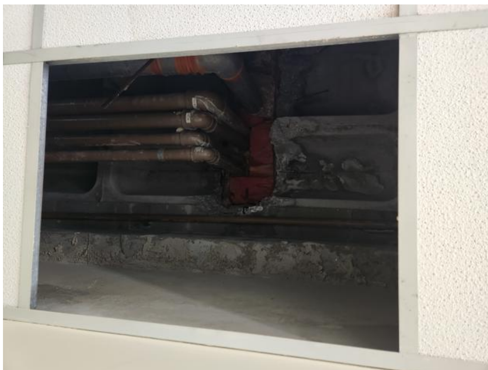
Imagem 75 – Descida de água com marcas de infiltração ao redor.
