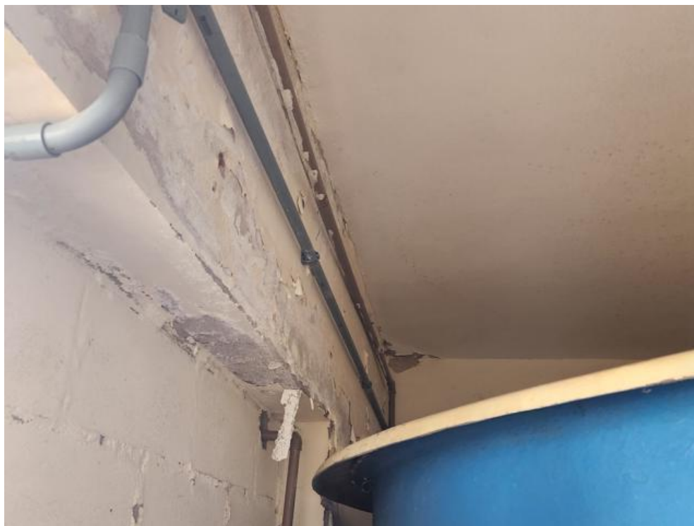
Imagem 45 - Área técnica das caixas de água - Marcas de infiltração na laje.
