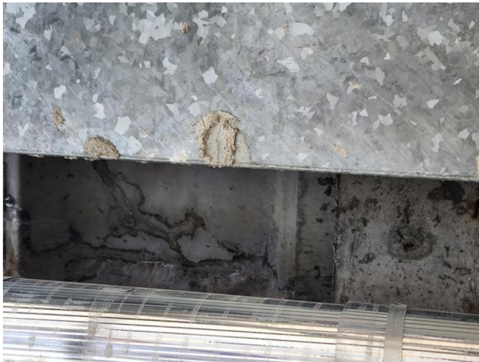
Imagem 66 - Sinais de carbonatação do concreto e oxidação das armaduras.
