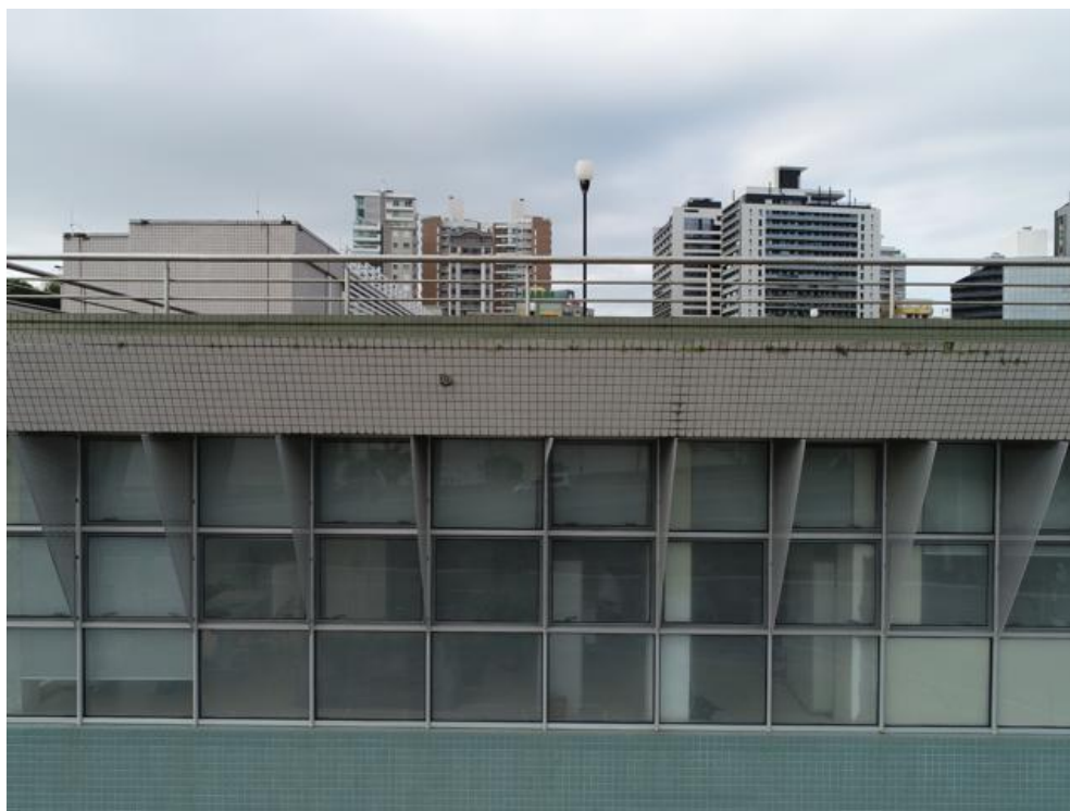
Imagem 238 - Presença de sujeira, vegetação, ausência de rejuntas e pingadeiras.
