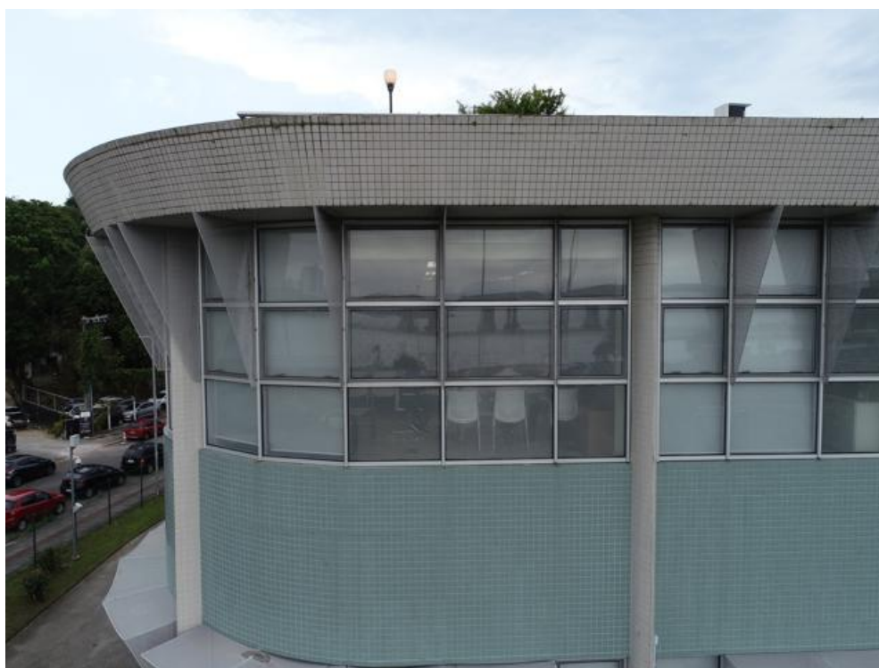
Imagem 217 – Fachada Nordeste - Ausência de pingadeiras nas bordas, presença de vegetação, ausência do rejunte branco
