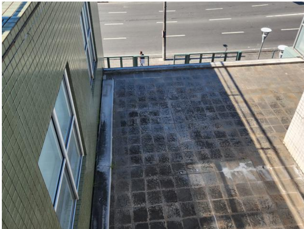
Imagem 56 – Laje sobre recepção – Marcas de carbonatação, sujeira e acúmulo de vegetação.
