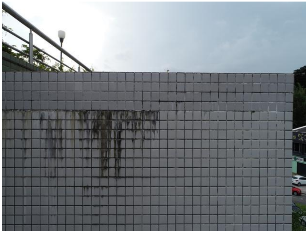
Imagem 170 – Reparo localizado com pastilha de diferente coloração, marca de infiltração com presença de sujeira e ausência de rejuntas.
