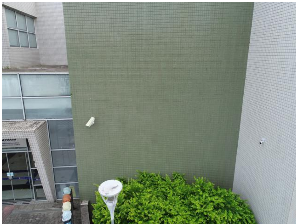
Imagem 153 – Presença de sujidade e ausência de rejuntas
