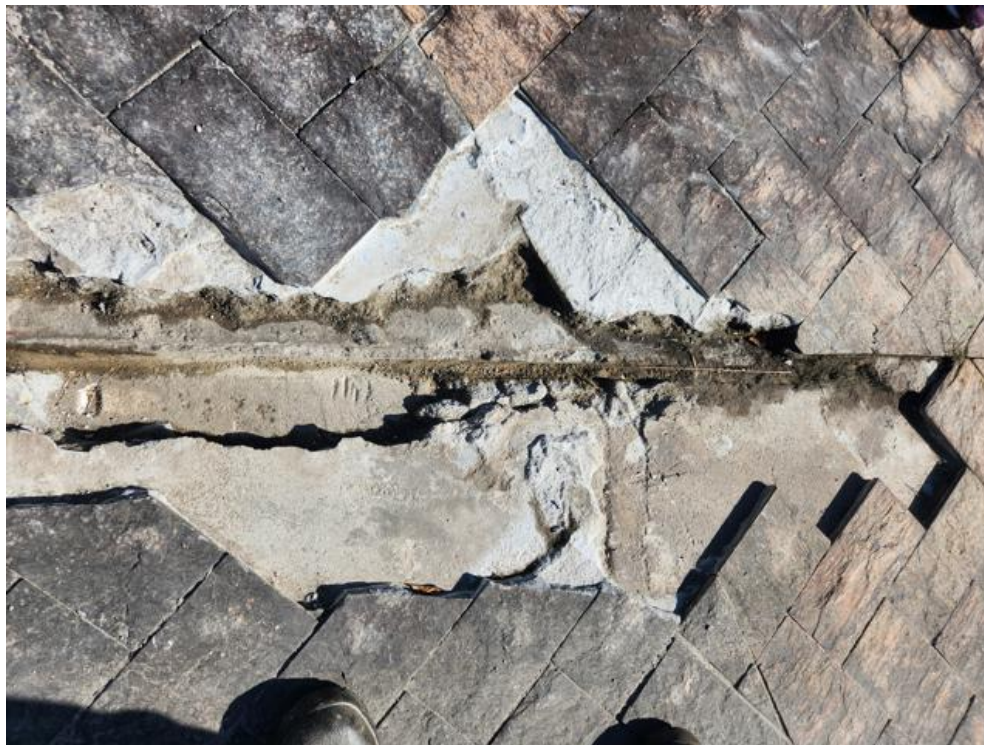
Imagem 22 – Junta de construção.
