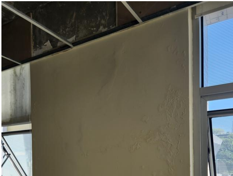
Imagem 96 – Marcas de danos no revestimento das paredes.
