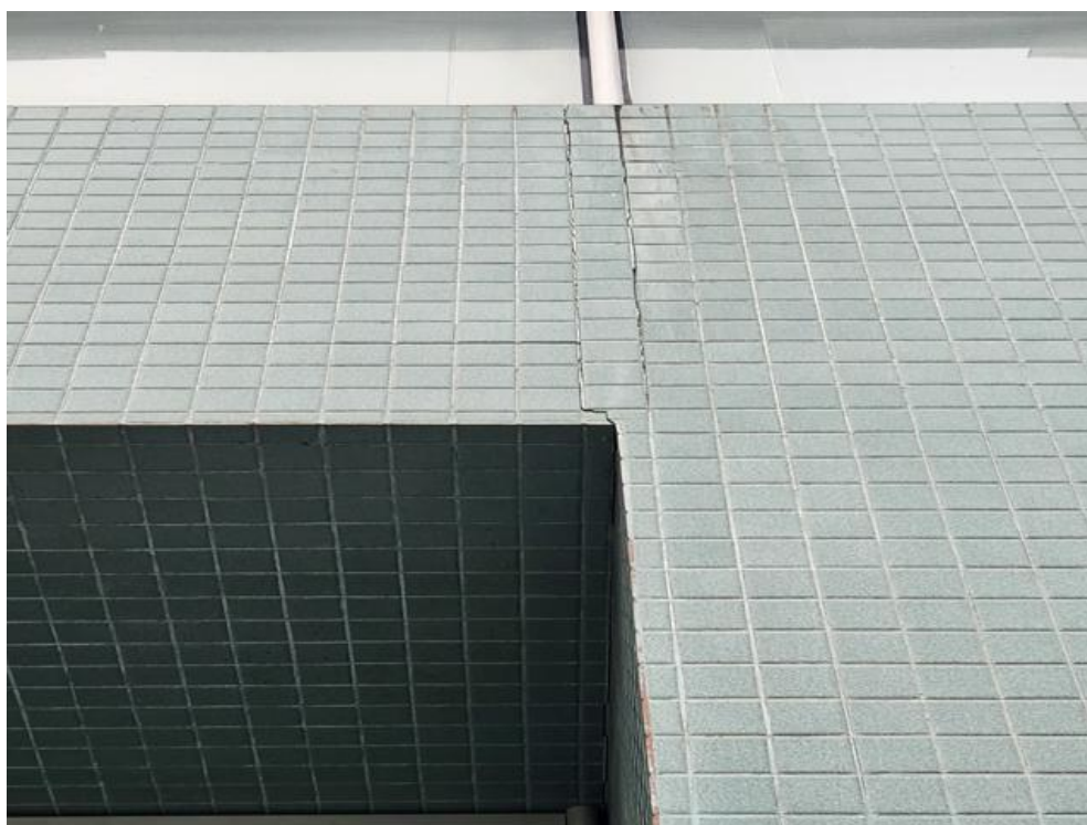
Imagem 143 – Pastilhas no alinhamento de junta de construção se soltando
