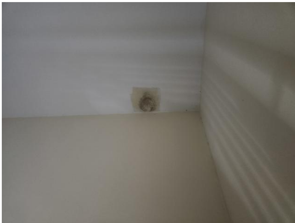
Imagem 64 – Presença de infiltração na laje.
