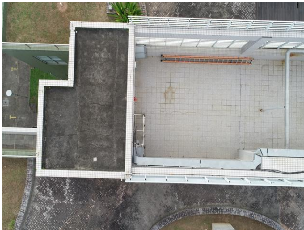
Imagem 134 – Áreas técnicas – Setores Verde, Magenta e Amarelo. Presença de sujeira nos rejuntos.
