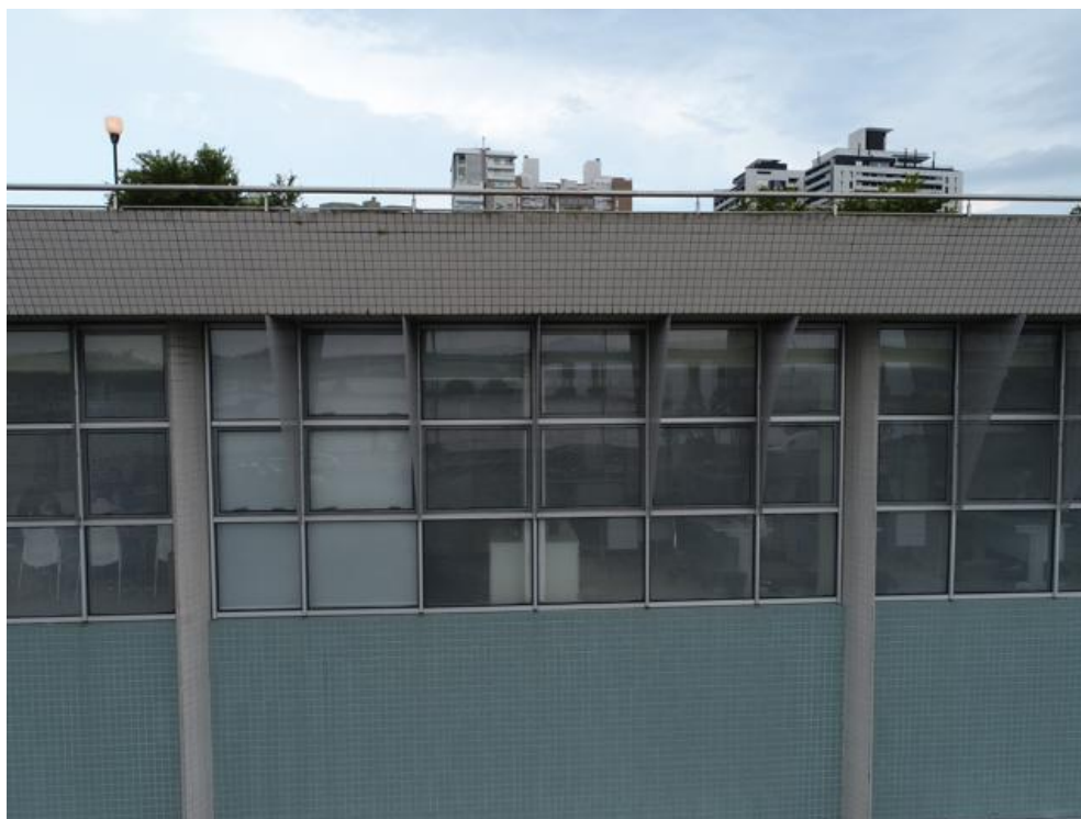
Imagem 218 - Fachada Nordeste – Presença de sujeira e vegetação, ausência de pingadeiras nas bordas e do rejunte branco.
