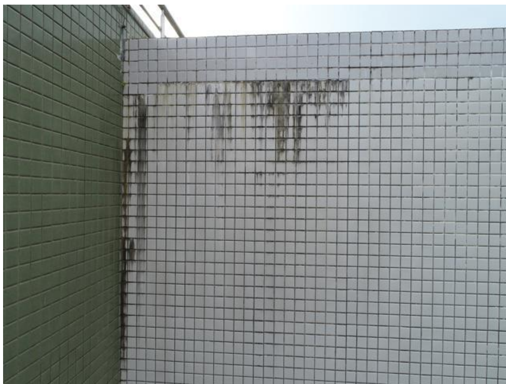
Imagem 171 - Reparo localizado com pastilha de diferente coloração, marca de infiltração com presença de sujeira e ausência de rejuntas.
