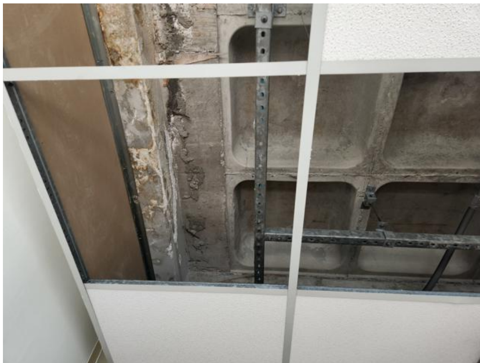
Imagem 95 - Marcas de infiltração severa com sinais de carbonatação e oxidação das armaduras.
