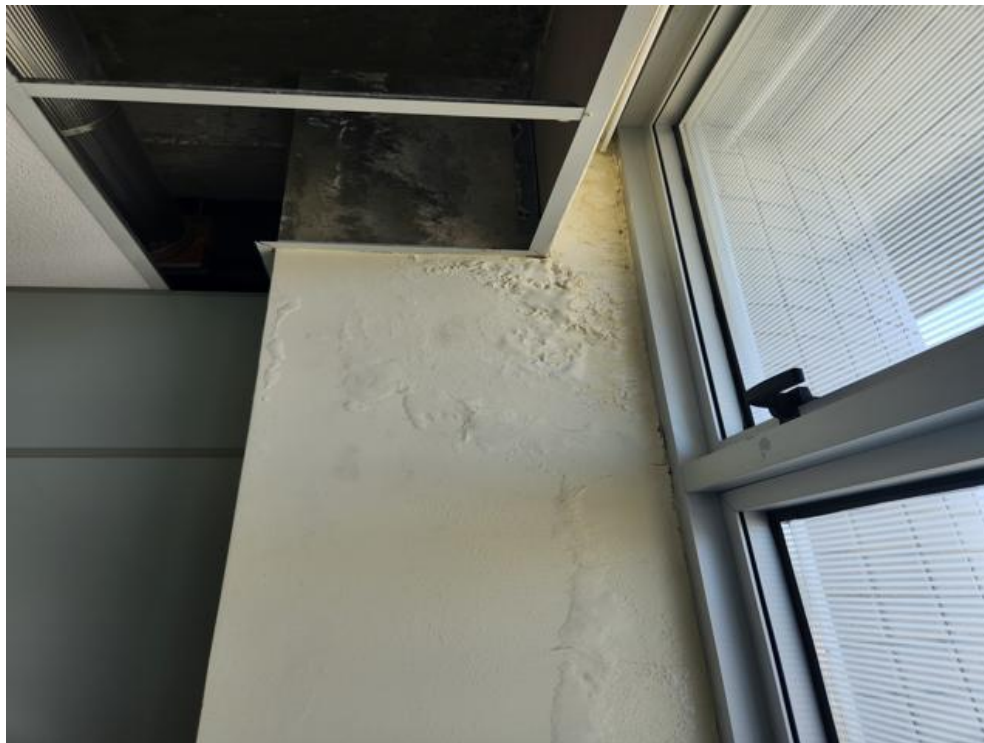
Imagem 110 - Marcas na laje e paredes de infiltração severa.
