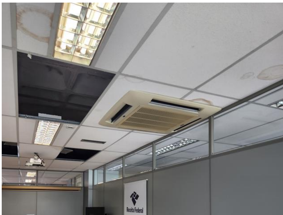
Imagem 87 – Marcas severas de infiltração.
