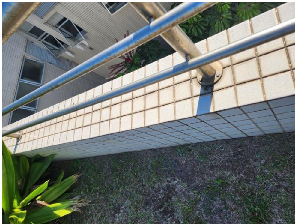
Imagem 25 - Imagem 26 – Pastilhas de revestimentos das muretas sem rejunte.
