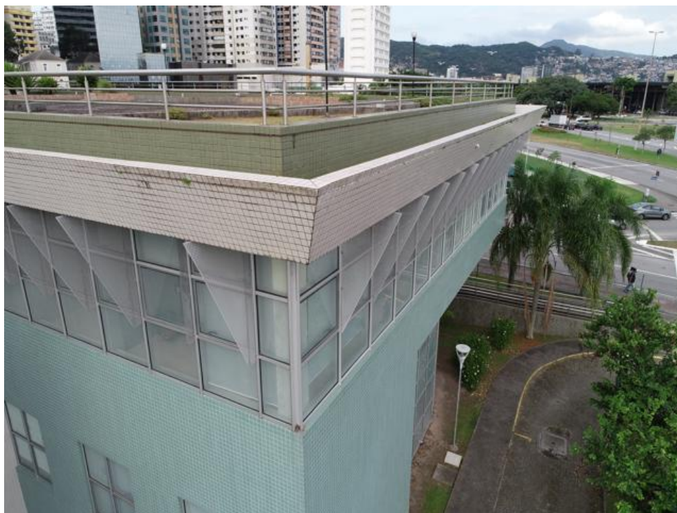
Imagem 216 – Ausência de pingadeiras nas bordas e presença de vegetação.
