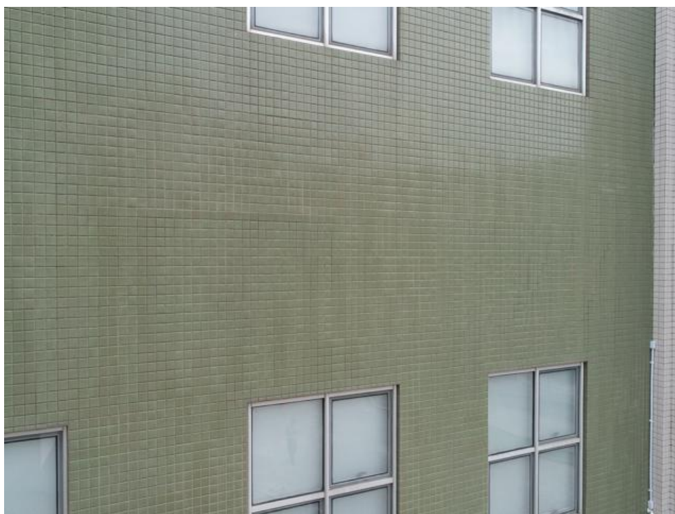
Imagem 199 - Sujeidade e ausência dos rejuntas. Deslocamento das pastilhas
