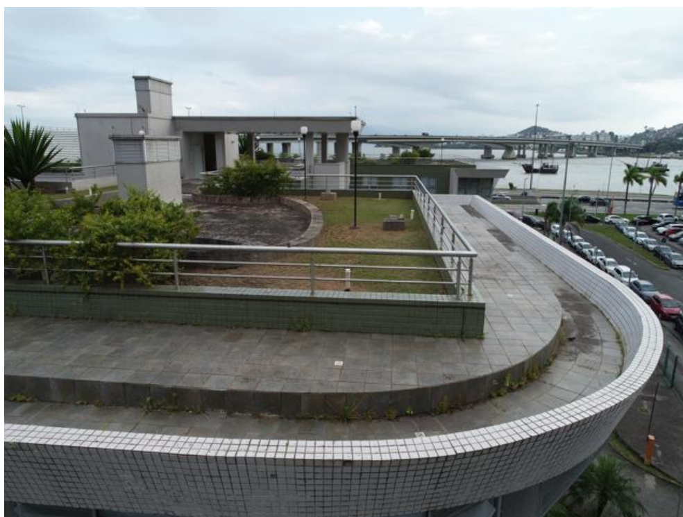
Imagem 177 – Imagem da calha estrutural, com grande presença de vegetação
