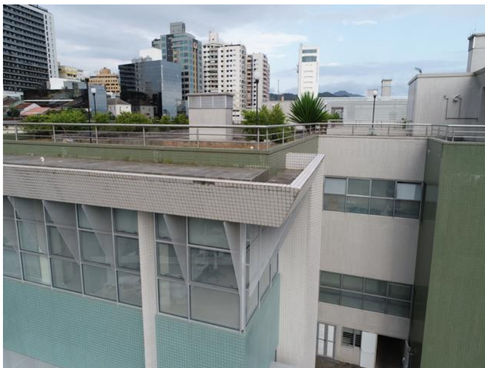
Imagem 183 - Lacunas nas pastilhas, presença de sujeira, vegetação e ausência das pingadeiras e rejuntas.
