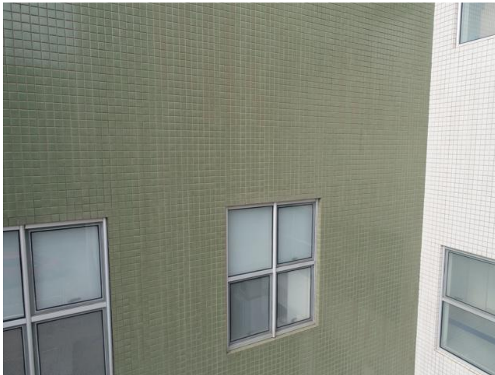
Imagem 186 - Presença de sujeira e ausência dos rejuntos.
