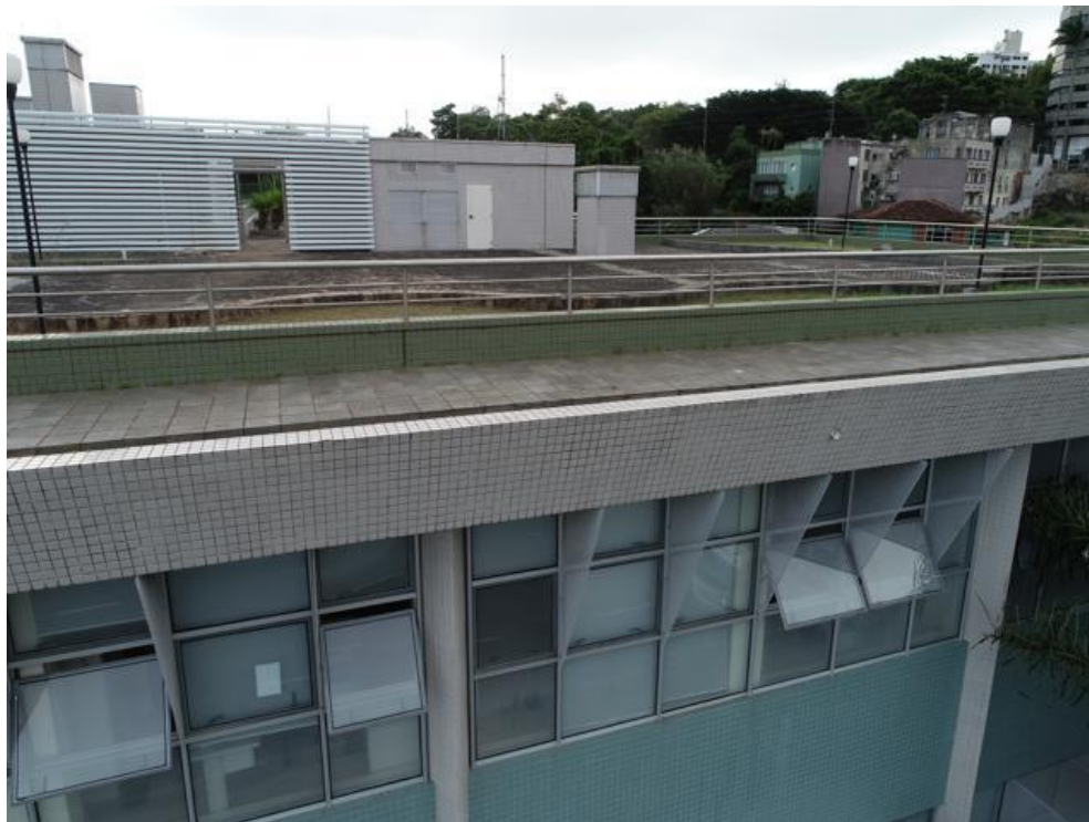
Imagem 150 - Ausência das pingadeiras, presença grande de sujidade e ausência dos rejuntos.
