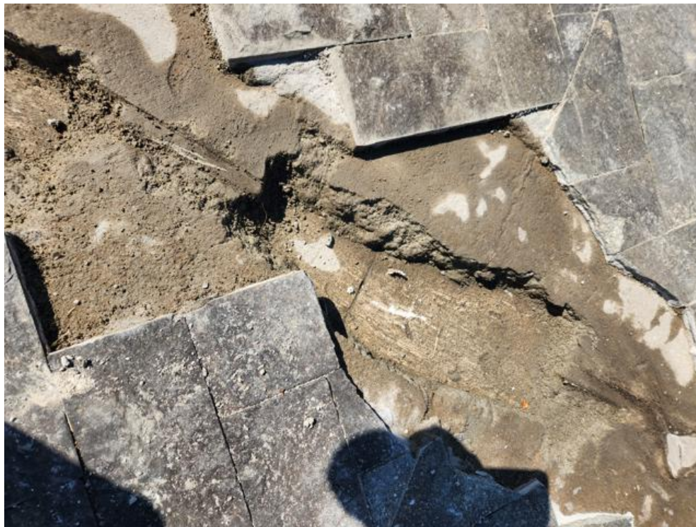
Imagem 34 – Junta de construção, aplicação de poliestireno abaixo da camada de regularização para assentamento das pedras Miracema.
