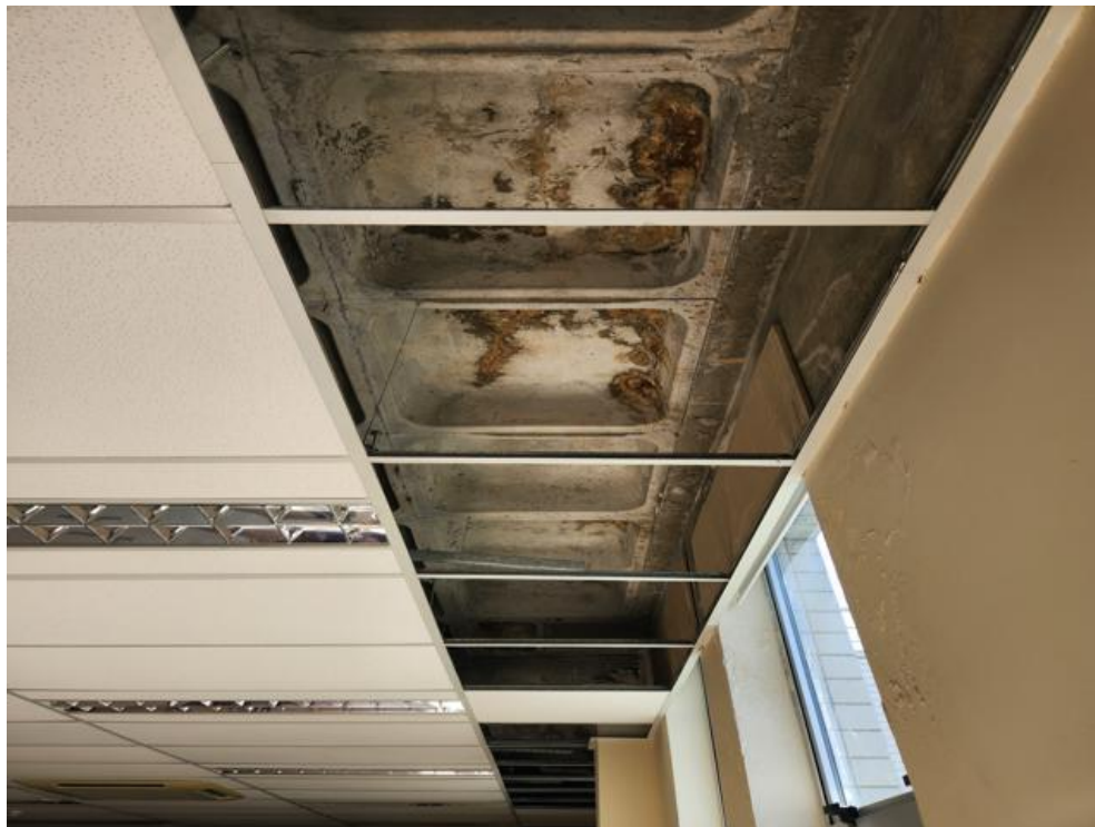
Imagem 108 – Marcas na laje e paredes de infiltração severa.
