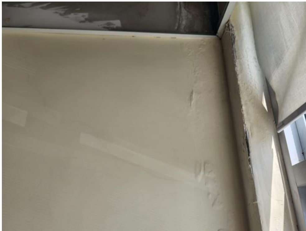
Imagem 98 - Marcas de danos no revestimento das paredes.
