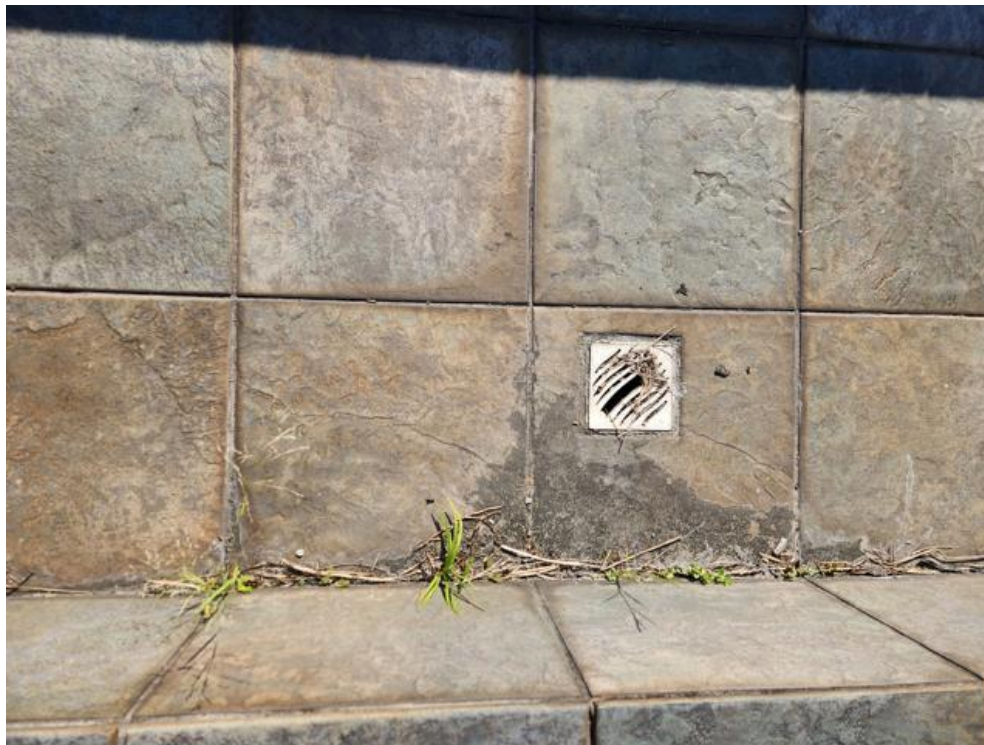
Imagem 6 – Ralo na calha estrutural setor azul.
