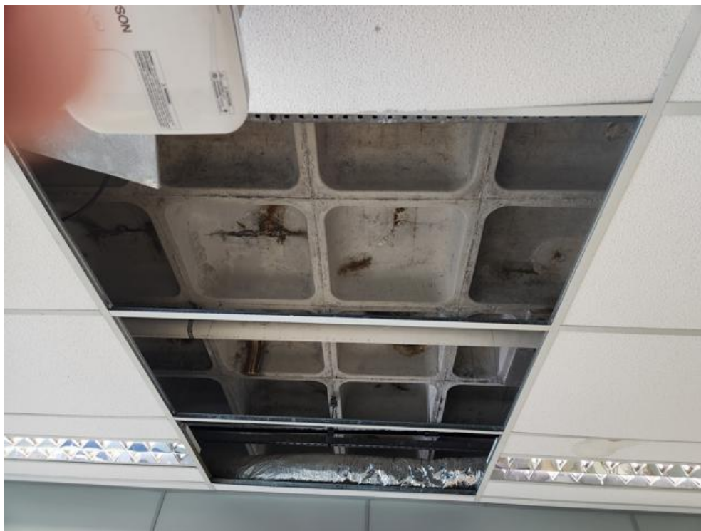
Imagem 83 - Marcas severas de infiltração causando carbonatação e oxidação da armadura da laje.
