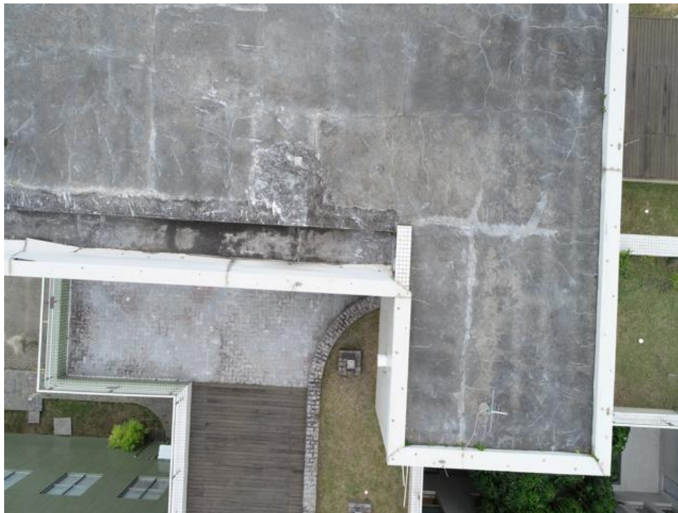
Imagem 112 – Marcas de infiltração, fissuras e de reparo em ralo com grelha plástica.
