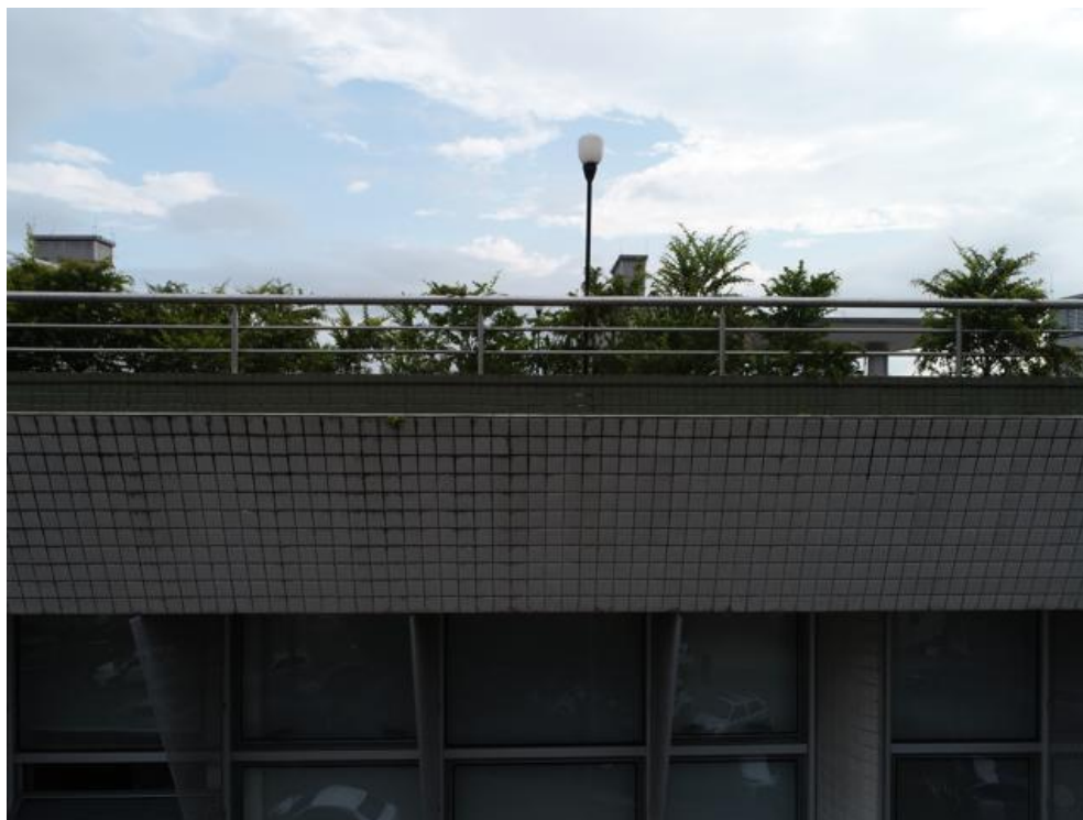
Imagem 173 - Lacunas nas pastilhas, presença de vegetação e sujeira, ausência de rejuntas e pingadeiras.
