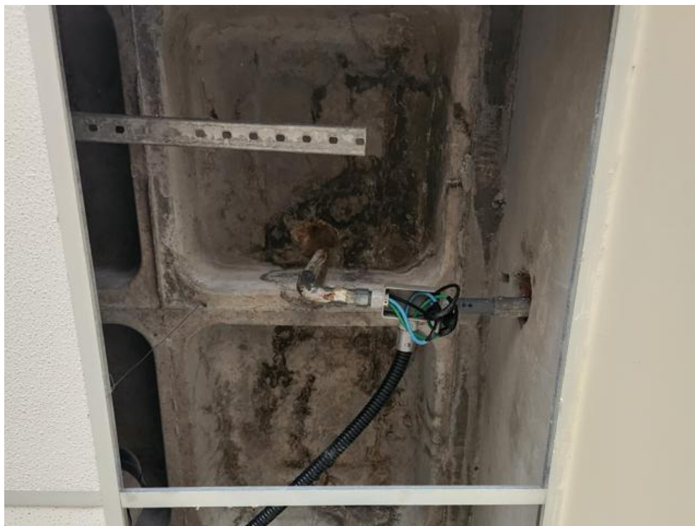
Imagem 103 – Infiltração ao redor de tubulação de subida dos sistemas elétricos.
