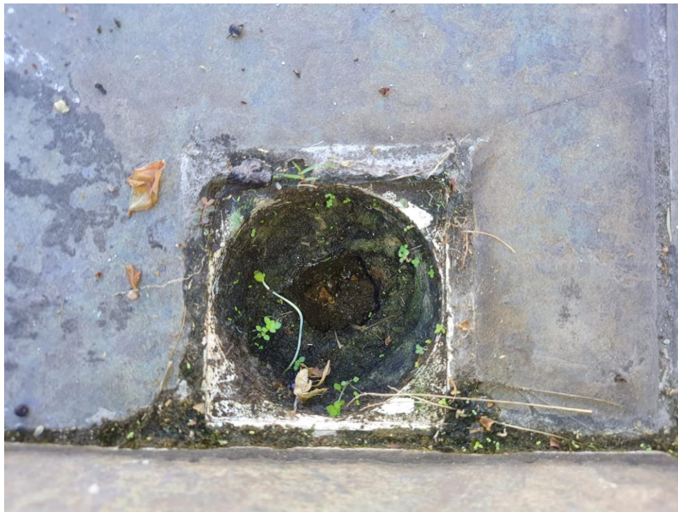
Imagem 48 – Ralo obstruído com pedaços da manta de impermeabilização e acúmulo de resíduos.
