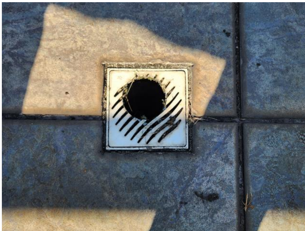
Imagem 17 – Grelha rompida para aumento de fluxo de captação
