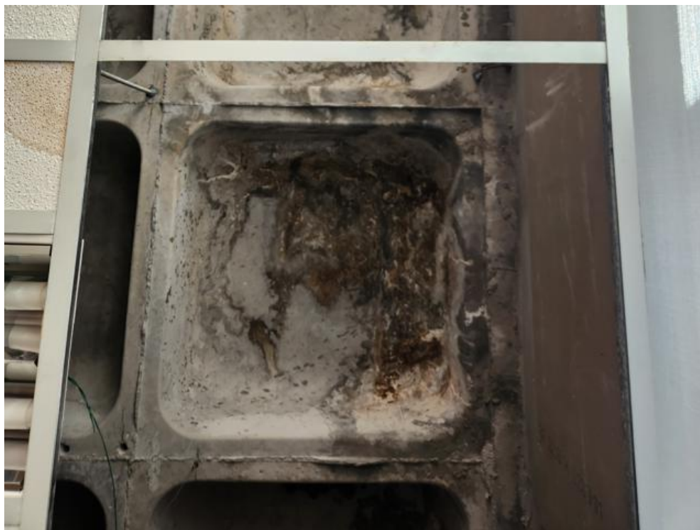
Imagem 104 – Marcas de infiltração severa na laje, com marcas de carbonatação e oxidação da armadura da laje.
