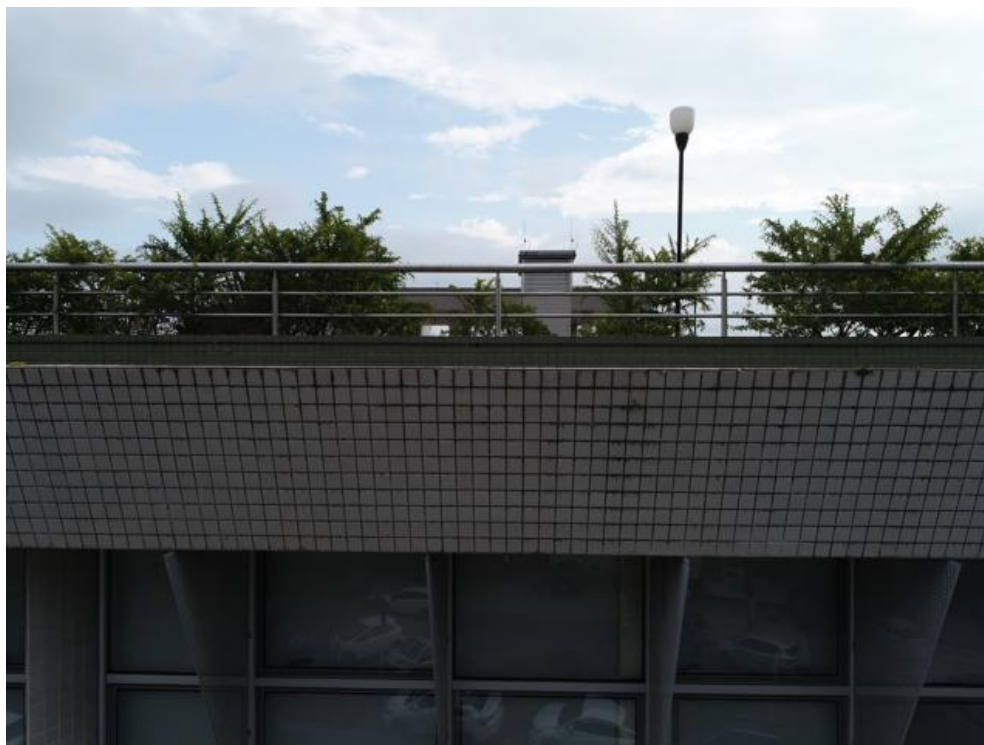
Imagem 175 - presença de vegetação e sujidade, ausência de rejuntas e pingadeiras.
