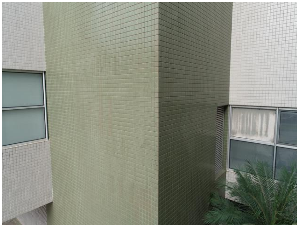
Imagem 197 - Sujeidade e ausência dos rejuntos.
