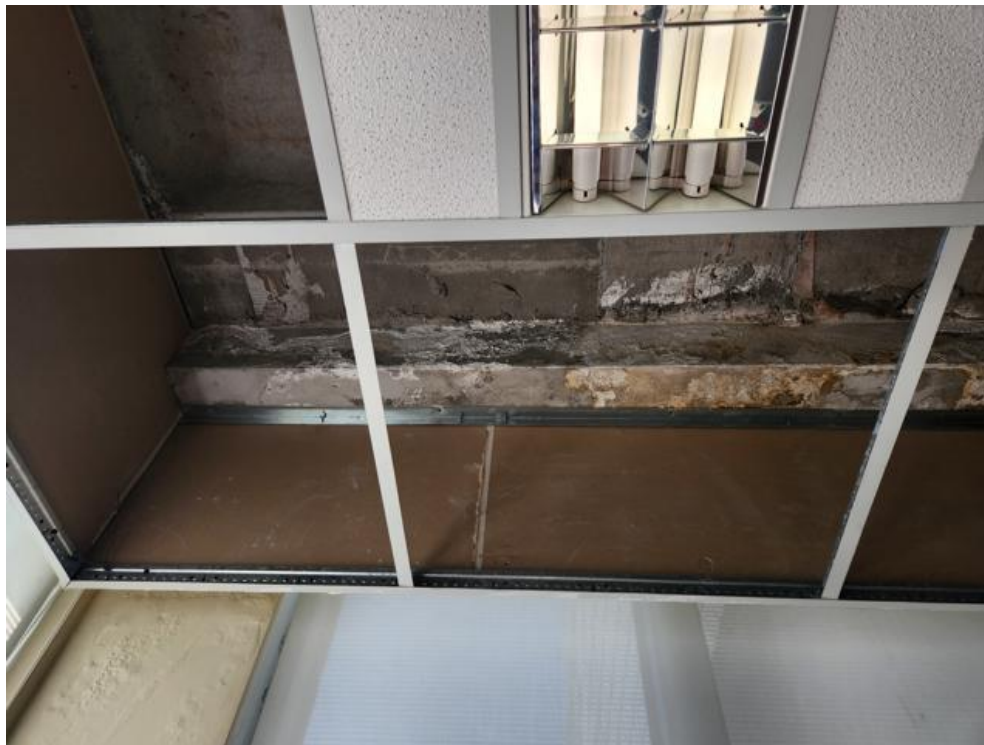
Imagem 94 – Marcas de infiltração severa com sinais de carbonatação e oxidação das armaduras.
