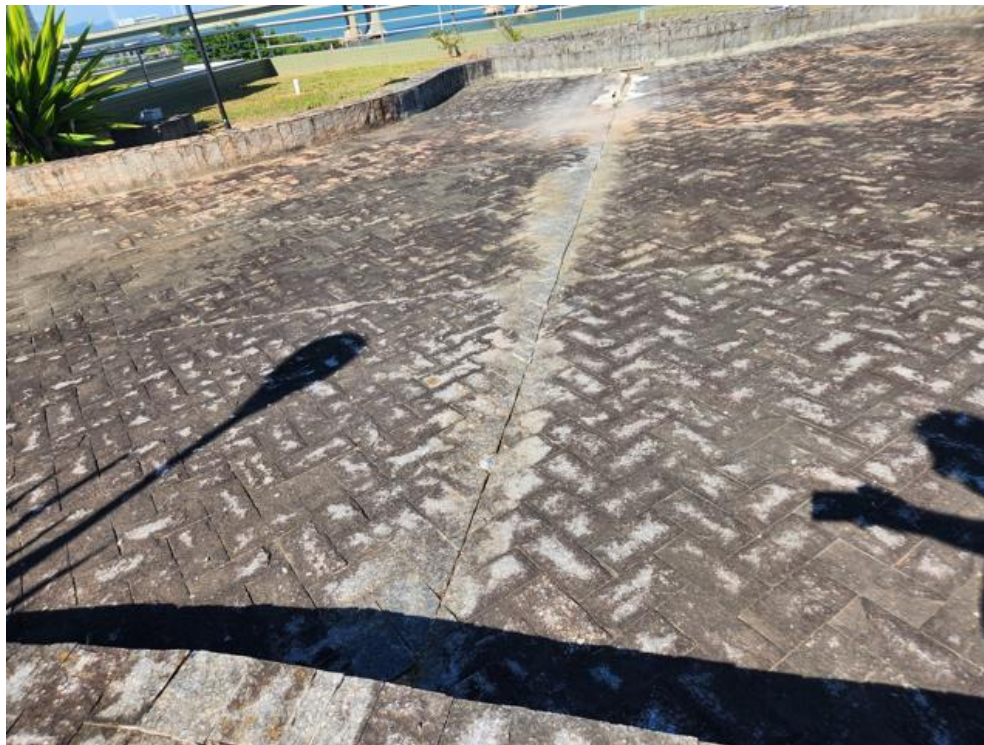
Imagem 28 – Junta de Construção – Setor azul / amarelo.
