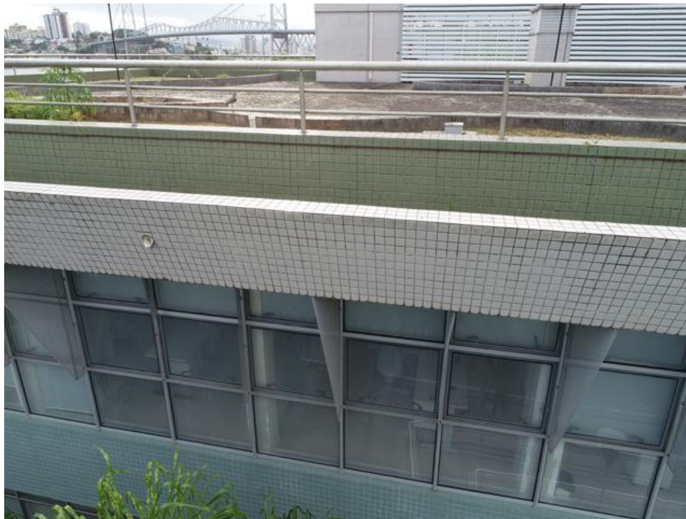
Imagem 162 - Pastilhas brancas sem rejunte e ausência de pingadeiras, inclusive no tampo de extravasamento das calhas estruturais.
