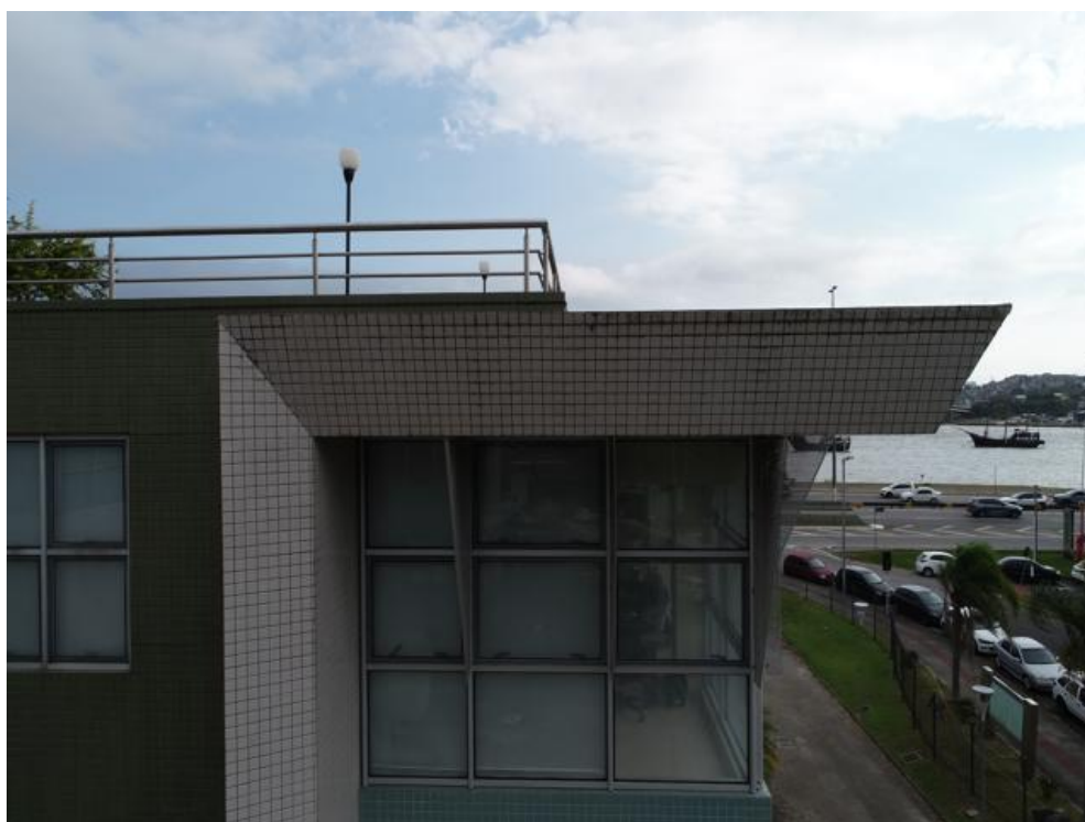
Imagem 203 - Sujeidade e ausência dos rejuntas. Presença de vegetação e ausência de pingadeiras.
