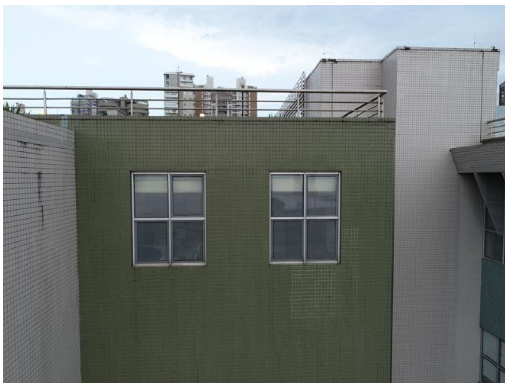
Imagem 223 - Fachada Nordeste – Presença de sujeira e vegetação, ausência de pingadeiras nas bordas e do rejunte branco e verde “musgo”.
