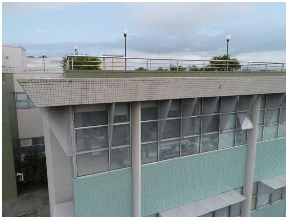
Imagem 206 - Sujeidade e ausência dos rejuntas. Presença de vegetação e ausência de pingadeiras.
