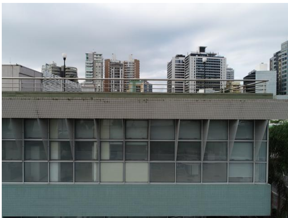
Imagem 239 - Presença de sujeira, vegetação, ausência de rejuntas e pingadeiras.
