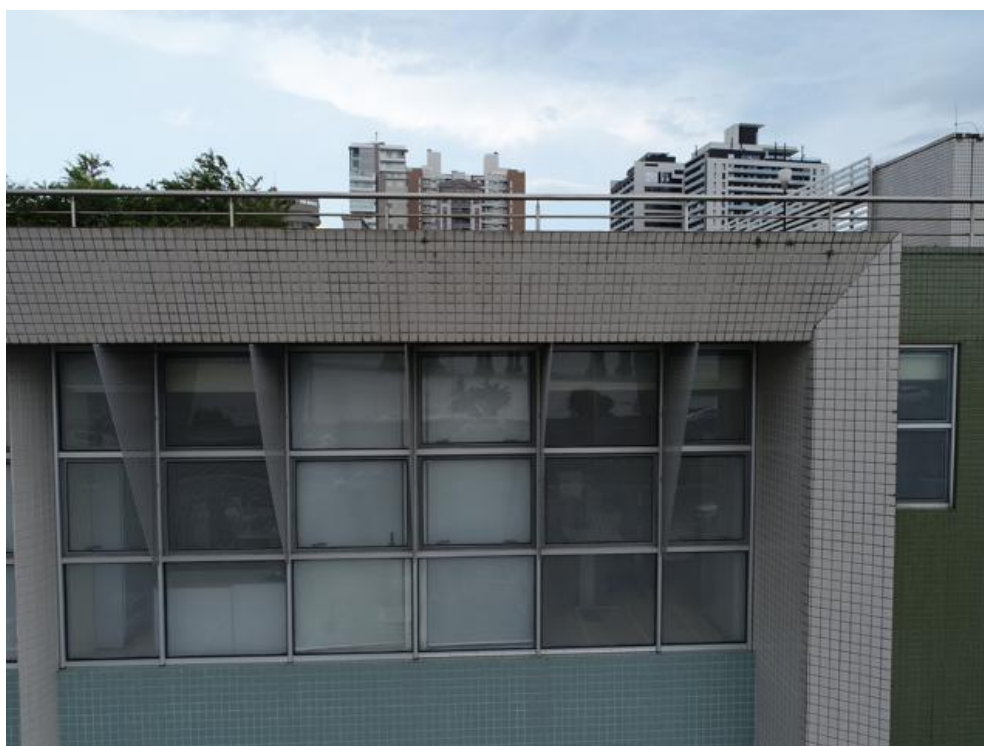
Imagem 221 - Fachada Nordeste – Presença de sujidade e vegetação, ausência de pingadeiras nas bordas e do rejunte branco.
