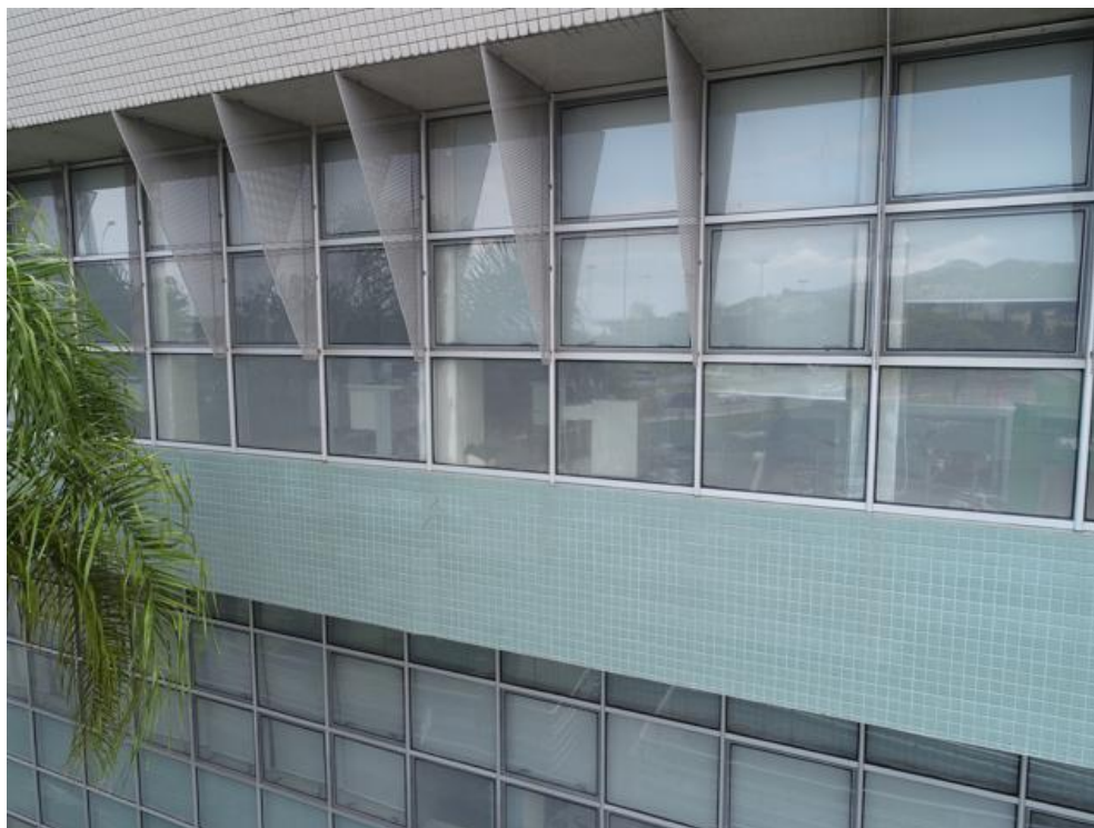
Imagem 160 - Pastilhas em verde claro com rejuntos em bom estado.
