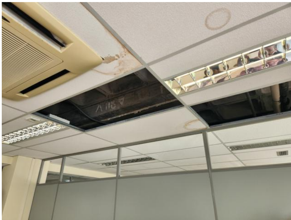
Imagem 72 – Placas de forro mineral danificadas.
