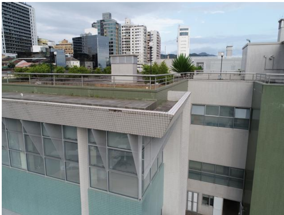
Imagem 182 - Lacunas nas pastilhas, presença de sujeira, vegetação e ausência das pingadeiras e rejuntas.
