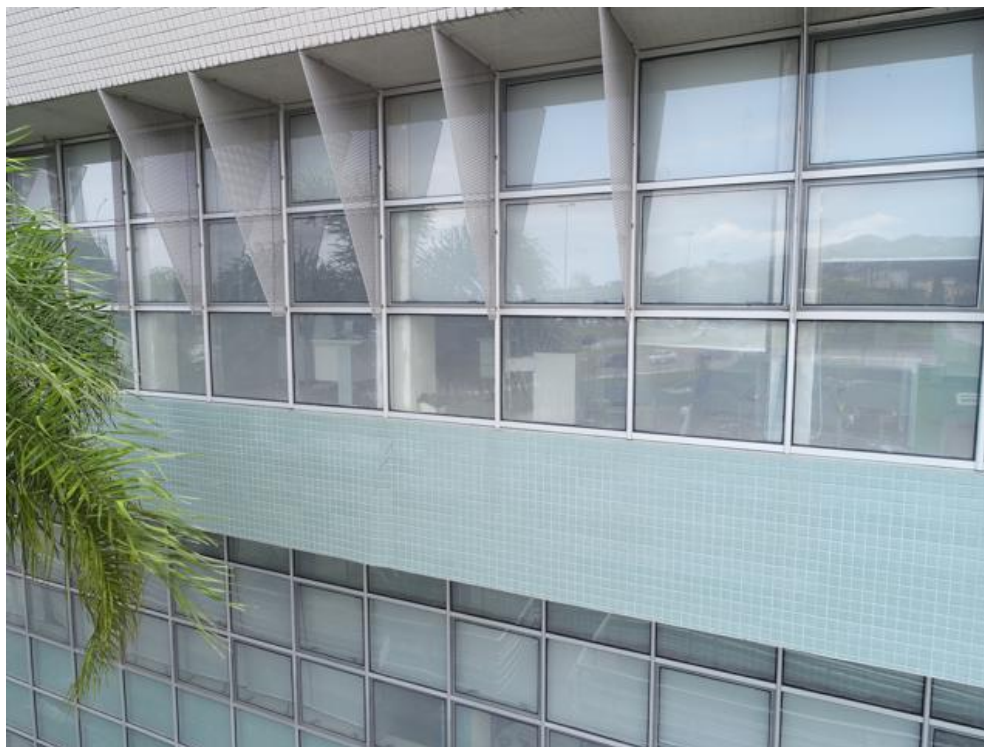
Imagem 159 – Pastilhas em verde claro com rejuntas em bom estado.
