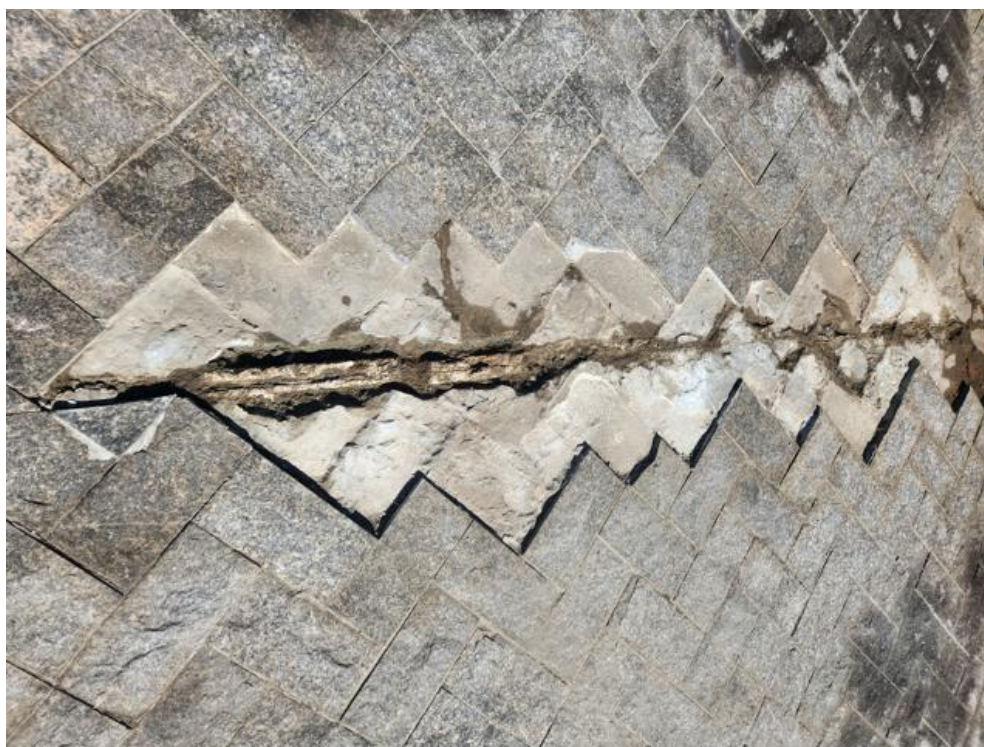
Imagem 51 - Junta de Construção – Setor Verde / Magenta.
