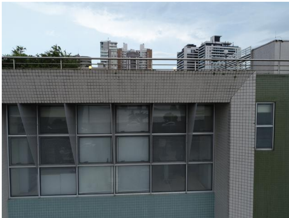
Imagem 222 - Fachada Nordeste – Presença de sujeira e vegetação, ausência de pingadeiras nas bordas e do rejunte branco.
