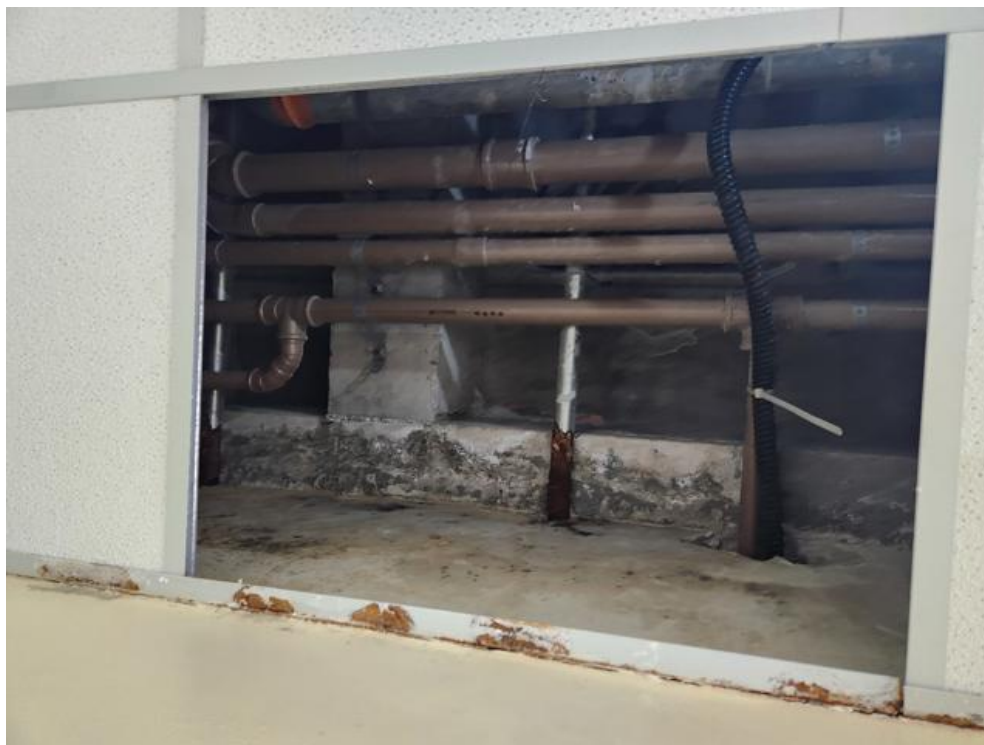
Imagem 77 – Marcas de Infiltração severa, tubos galvanizados corroídos, danos nos perfis e placas do forro mineral.
