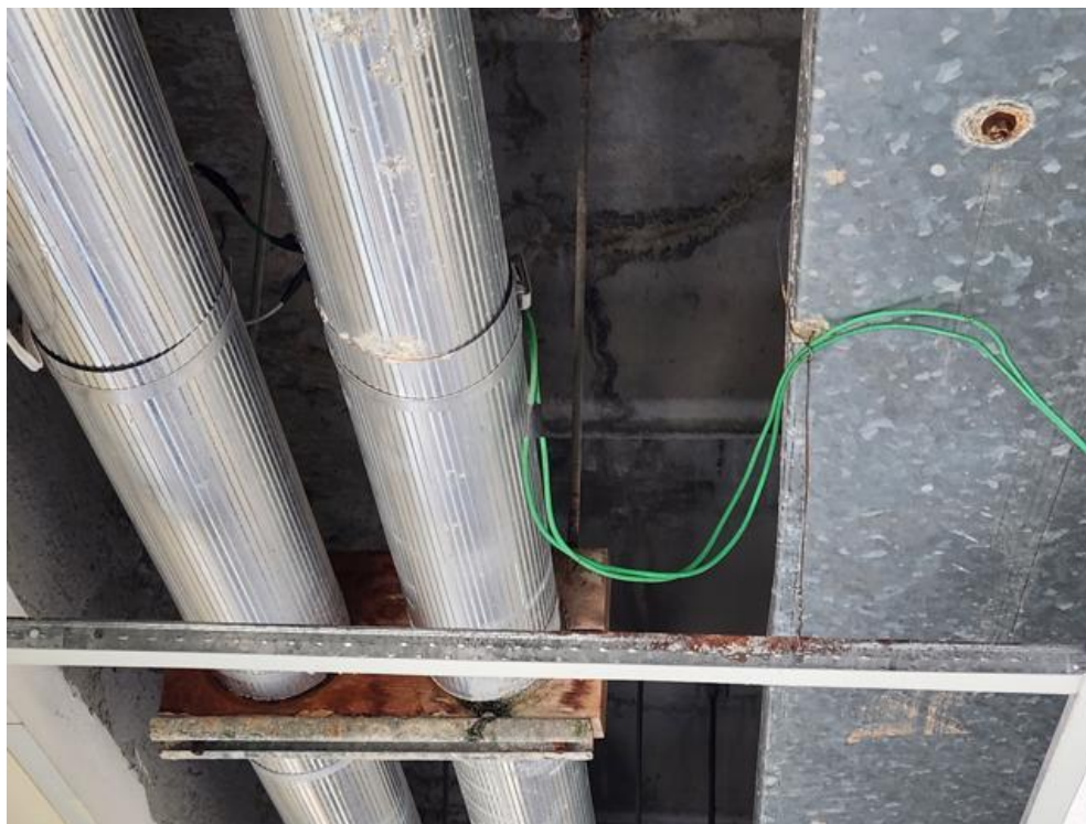
Imagem 67 – Fiação elétrica em desconformidade.
