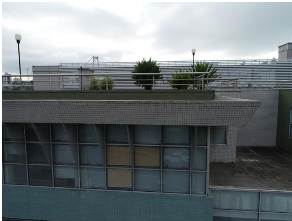
Imagem 157 - Presença de sujeira, ausência de pingadeiras e rejuntas.
