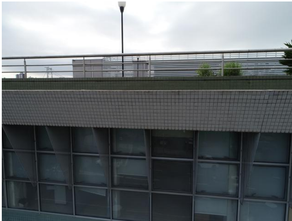
Imagem 158 - Presença de sujeira, ausência de pingadeiras e rejuntas.
