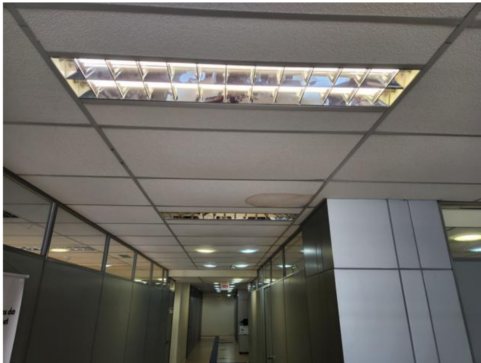
Imagem 80 – Placa de forro mineral danificada.
