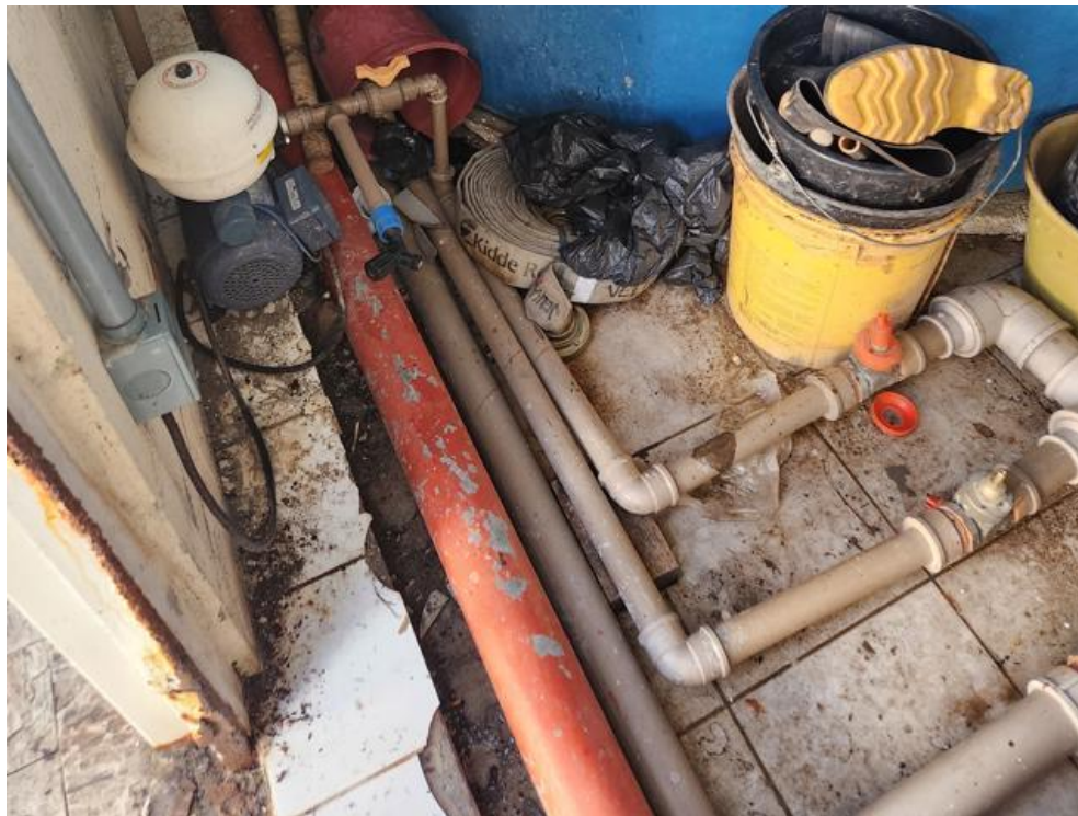
Imagem 42 - Área técnica das caixas de água – Caixilhos corroídos, revestimento bastante quebrado e sujo.
