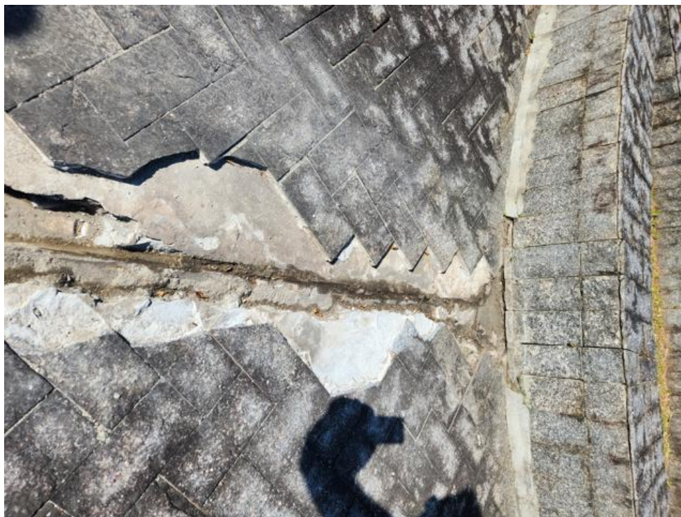
Imagem 23 – Junta de Construção.
