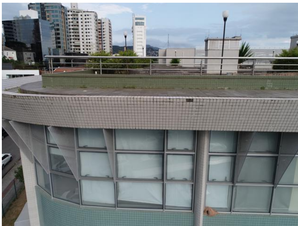
Imagem 179 - Lacunas nas pastilhas, presença de sujeira, vegetação e ausência das pingadeiras e rejuntas.
