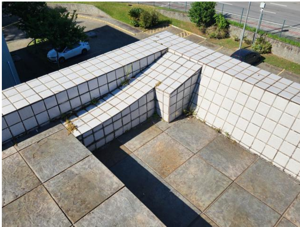
Imagem 18 – Detalhes das platibandas com presença de vegetação e ausência de rejuntas e pingadeiras.
