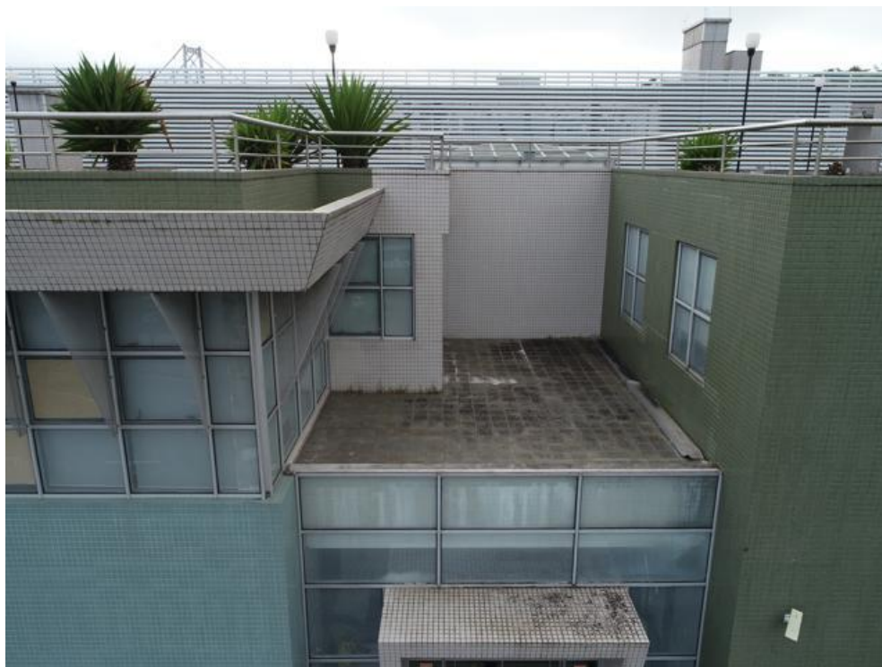
Imagem 155 – Presença severa de sujeira nas coberturas de laje e ardósia
