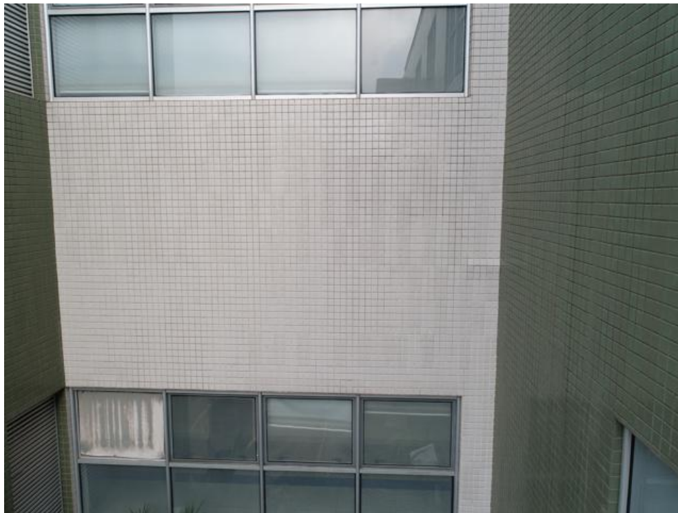
Imagem 196 - Sujeidade e ausência dos rejuntos. Desplacamento de pastilhas.
