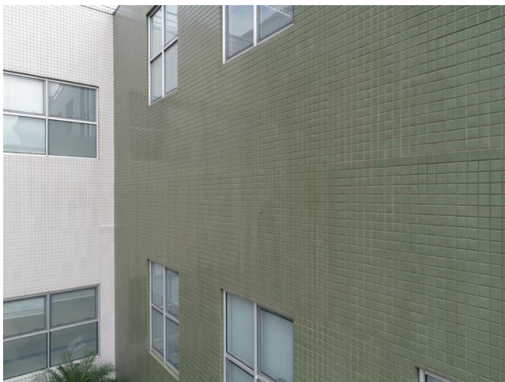
Imagem 201 - Sujidade e ausência dos rejuntas. Deslocamento das pastilhas.
