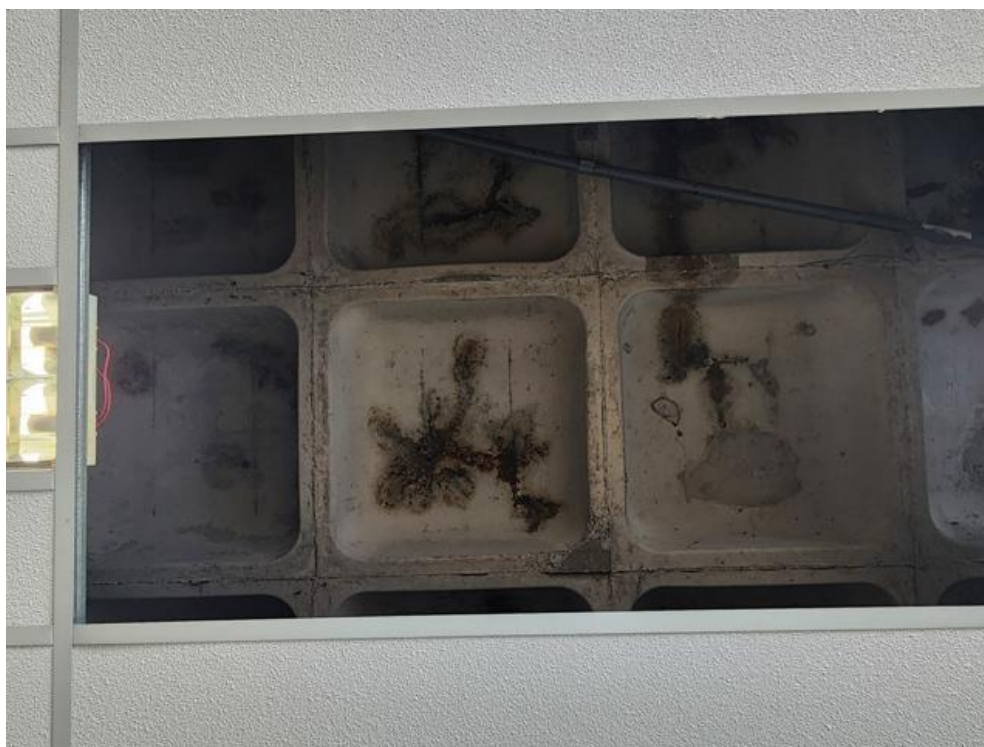
Imagem 81 – Marcas severas de infiltração causando carbonatação e oxidação da armadura da laje.
