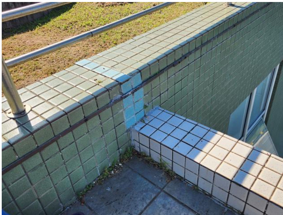
Imagem 19 – Reparos com pastilhas de cor diferente, barra chata do SPDA – Junta setor azul/amarelo
