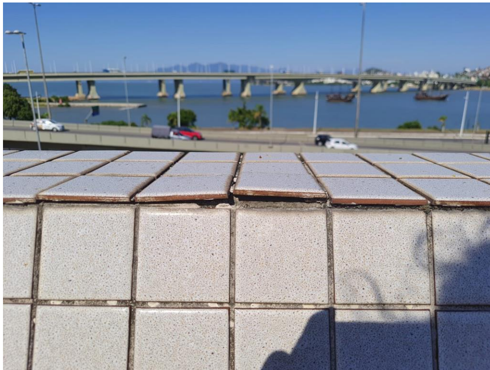
Imagem 36 – Pastilhas soltas e ausência do rejunte.
