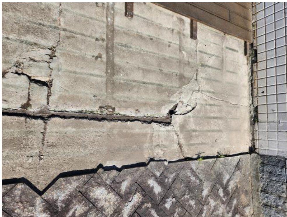
Imagem 33 – Junta de construção abaixo do deck, marcas de tentativa de reparo. Setor ciano / vermelho.
