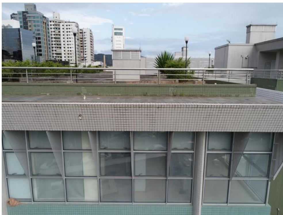
Imagem 181 - Lacunas nas pastilhas, presença de sujeira, vegetação e ausência das pingadeiras e rejuntas.
