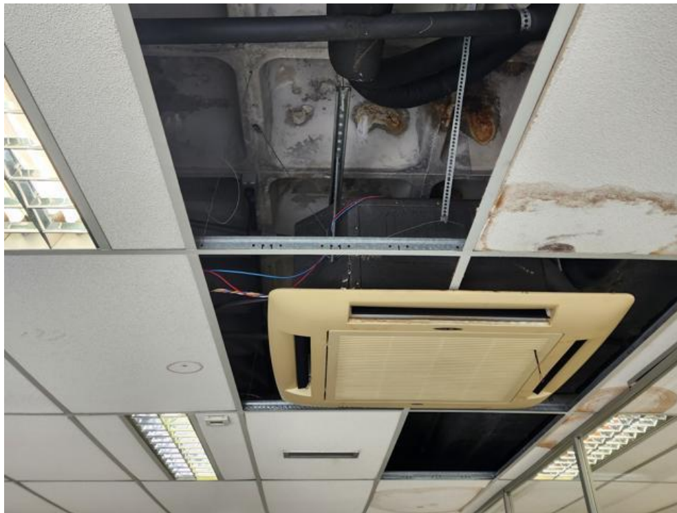
Imagem 90 - Marcas severas de infiltração na laje, danos nas placas de forro mineral, risco de danos em equipamentos.
