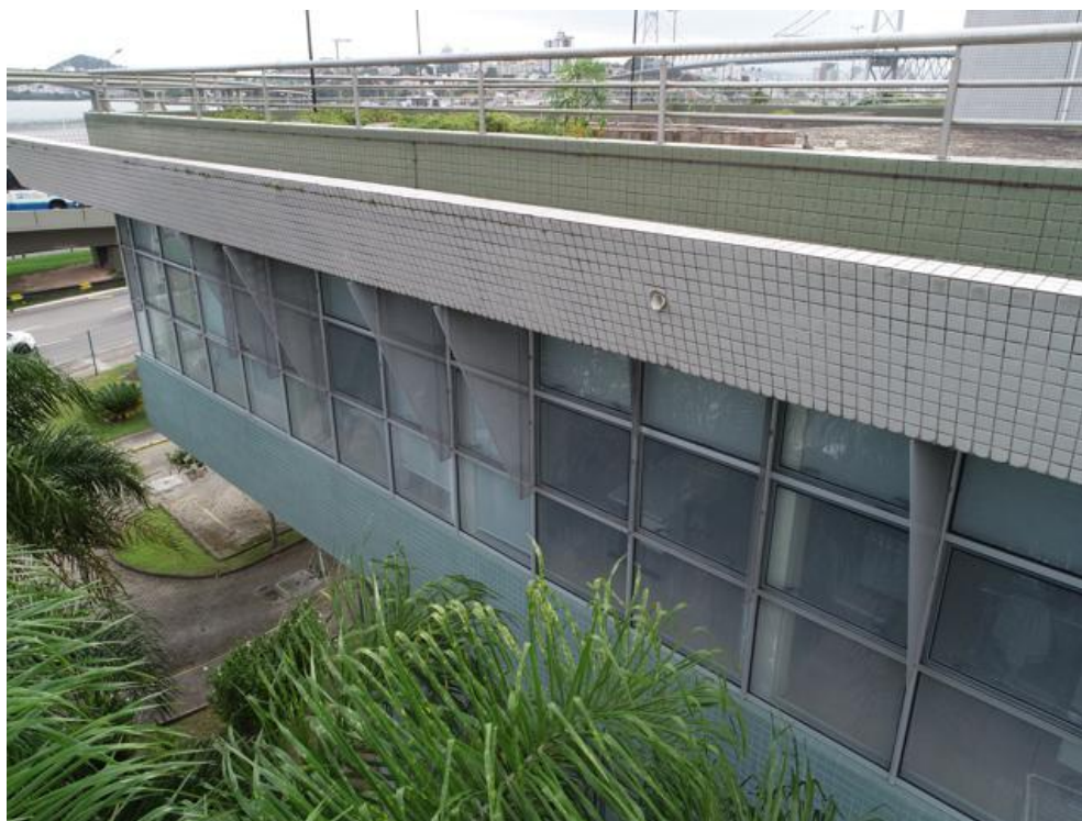
Imagem 161 – Pastilhas brancas sem rejunte e ausência de pingadeiras, inclusive no tudo de extravasamento das calhas estruturais.
