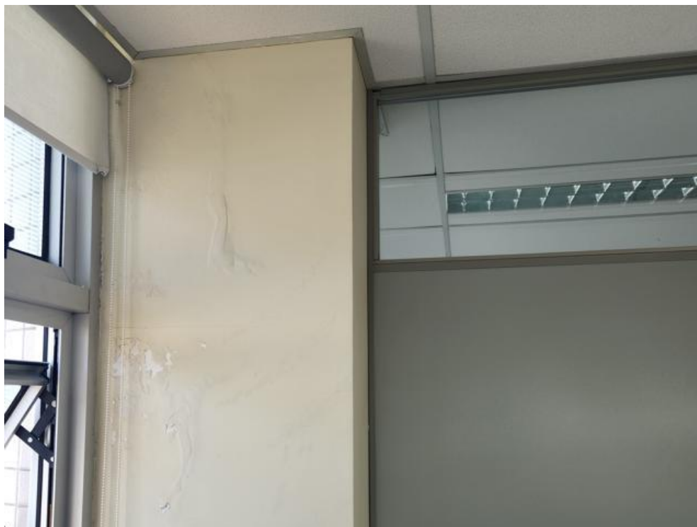
Imagem 97 - Marcas de danos no revestimento das paredes.
