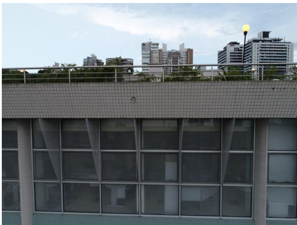
Imagem 219 - Fachada Nordeste – Presença de sujeira e vegetação, ausência de pingadeiras nas bordas e do rejunte branco.
