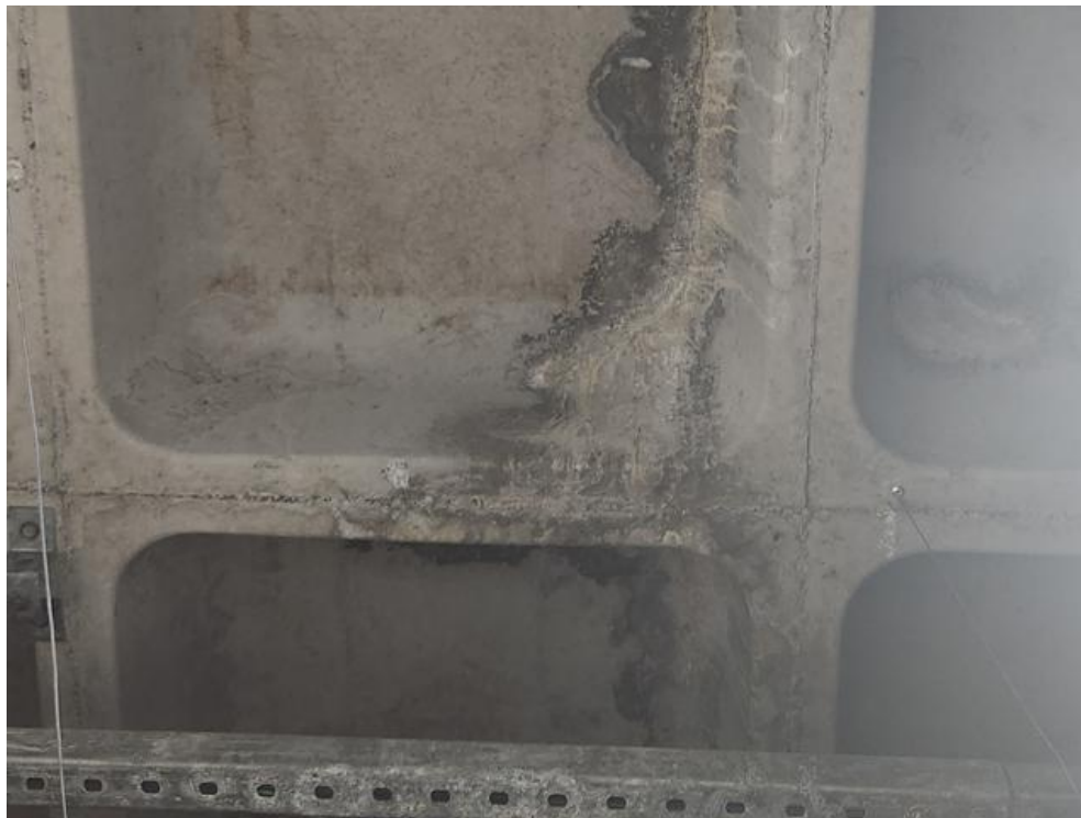
Imagem 102 – Marcas de infiltração na laje.
