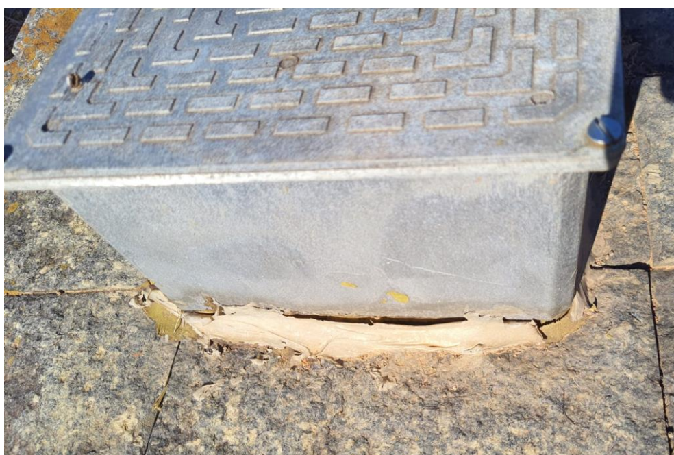
Imagem 47 – Caixa de passagem – Setor verde – Revestimento inadequado.
