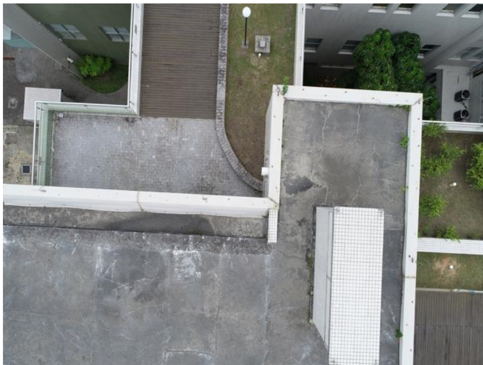
Imagem 113 – Presença de vegetação, fissuras e ausência de rejunte no revestimento com pastilhas.
