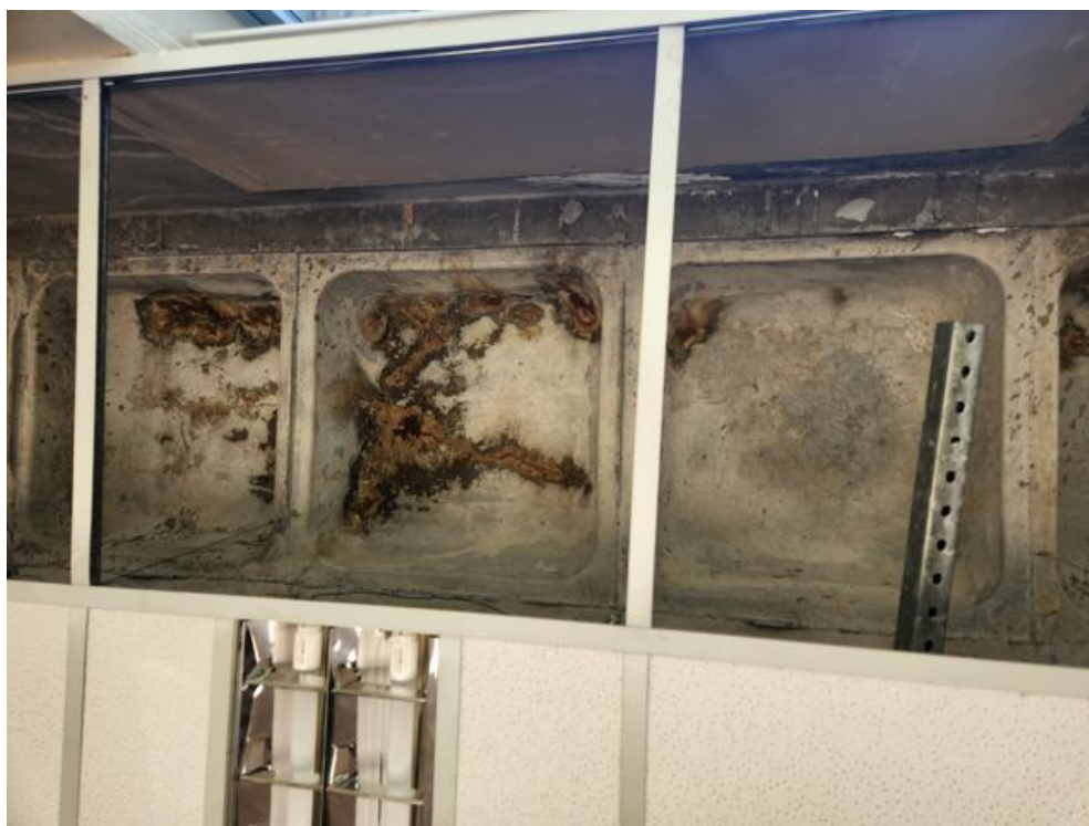
Imagem 105 - Imagem 117 – Marcas de infiltração severa.
