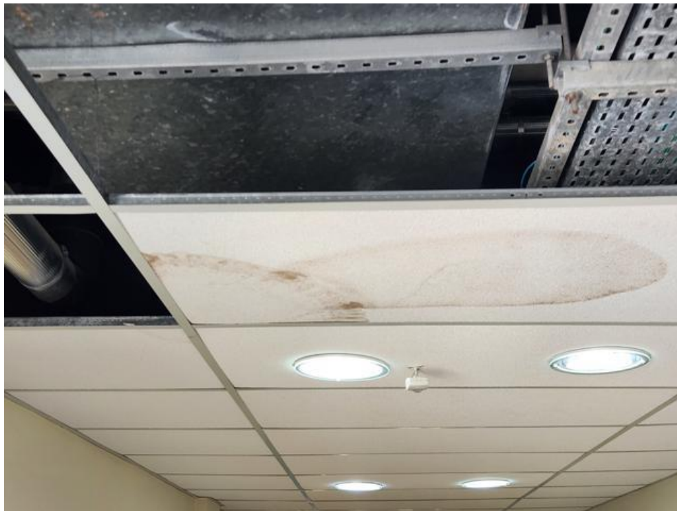
Imagem 68 – Danos nas placas de forro mineral.
