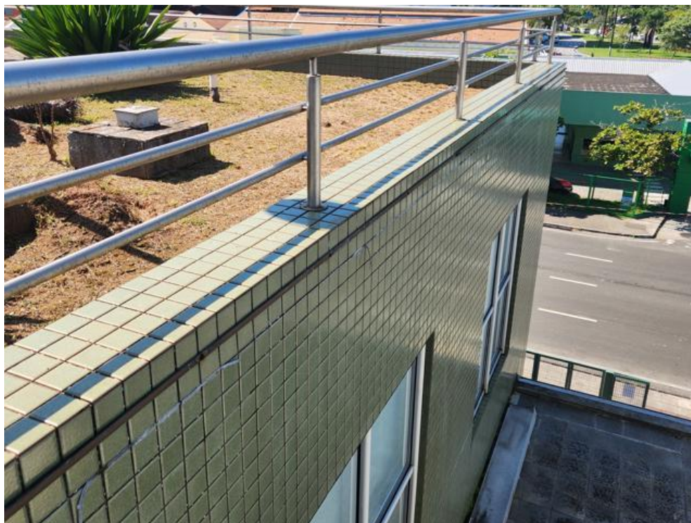
Imagem 57 – Fixação de barras chatas SPDA – Marcas de rejunte se soltando.
