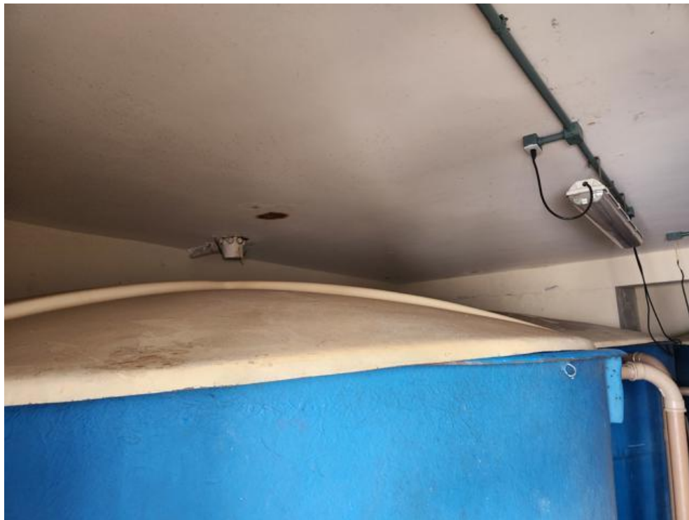
Imagem 44 – Área técnica das caixas de água - Marcas de infiltração na laje.
