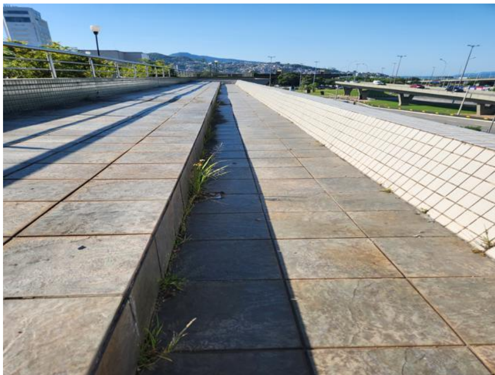
Imagem 13 – Calha estrutural revestida em ardósia – setor azul - presença de vegetação e ausência dos rejuntas.
