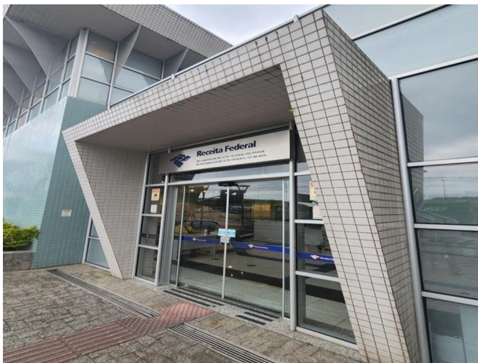
Imagem 145 - Pastilhas brancas e verdes com ausência praticamente total dos rejuntas, cobertura em pastilhas com ausência de pingadeiras.
