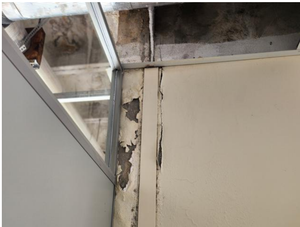
Imagem 74 – Marcas de infiltração severa próxima à junta de construção.
