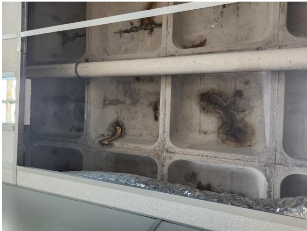
Imagem 88 – Marcas severas de infiltração na laje.
