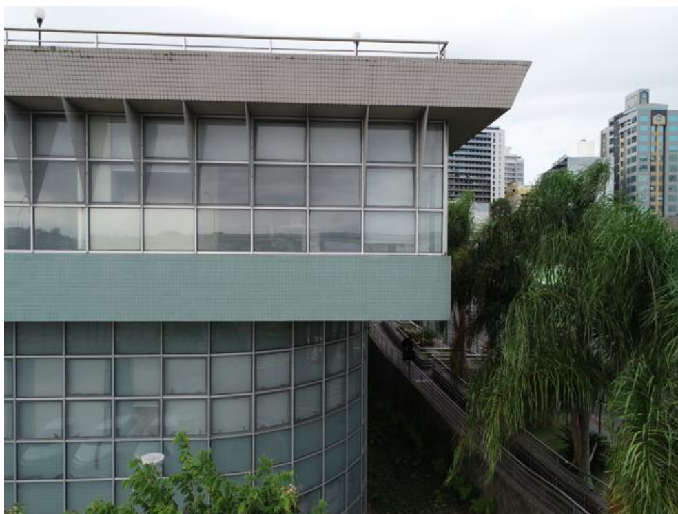
Imagem 240 - Presença de sujeira, vegetação, ausência de rejuntas e pingadeiras – Trecho com pastilhas verde claro em bom estado.
