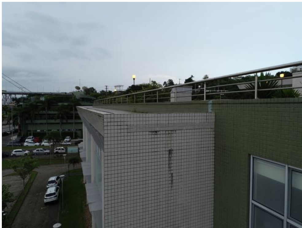
Imagem 224 – Reparos realizados com outra cor de pastilha, presença de vegetação e sujeira.
