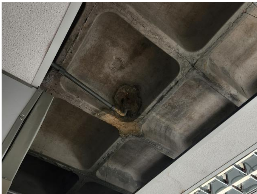
Imagem 93 – Infiltração em subida de tubulação elétrica/eletrônica.
