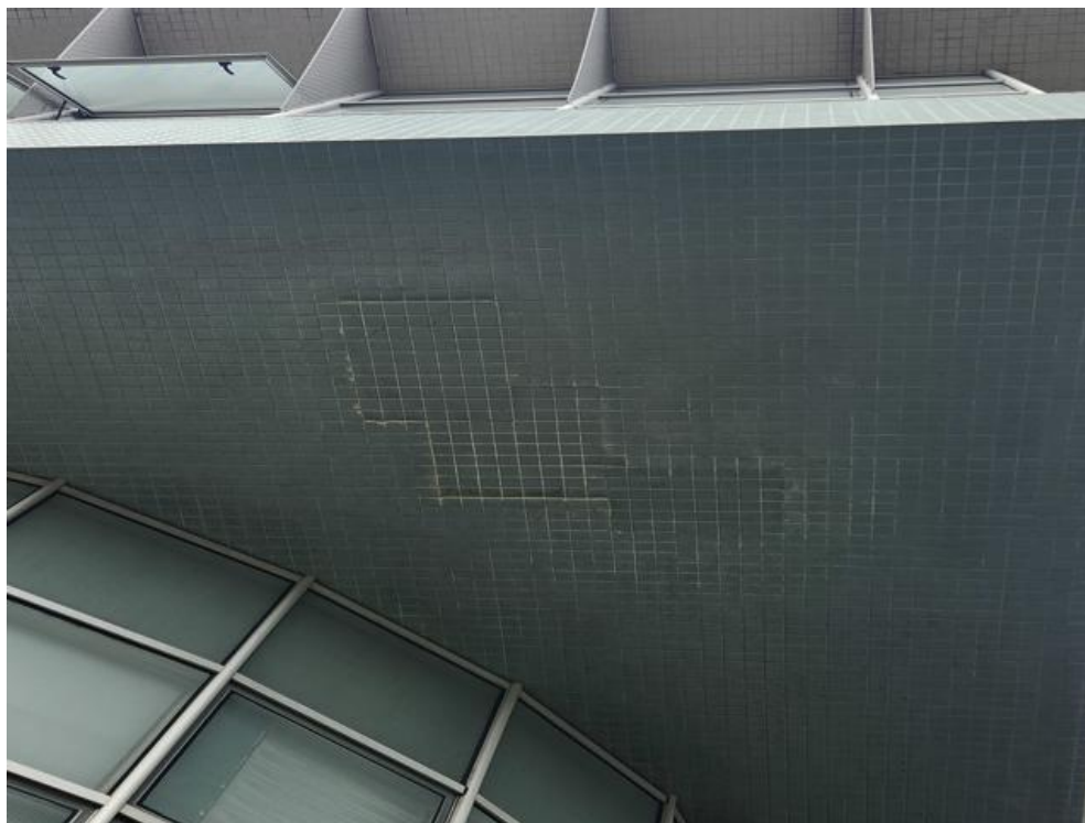
Imagem 147 – Reparo com Pastilhas com aplicação de rejunte de cor diferente
