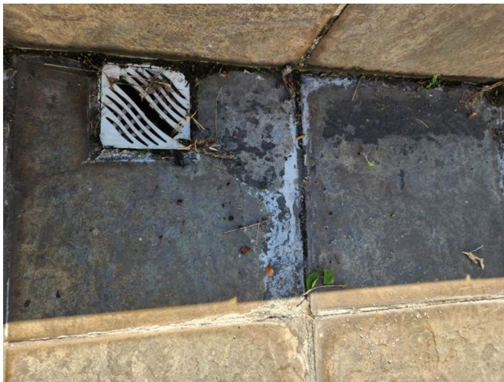
Imagem 20 – Grelha quebrada com muita presença de vegetação e marcas de carbonatação
