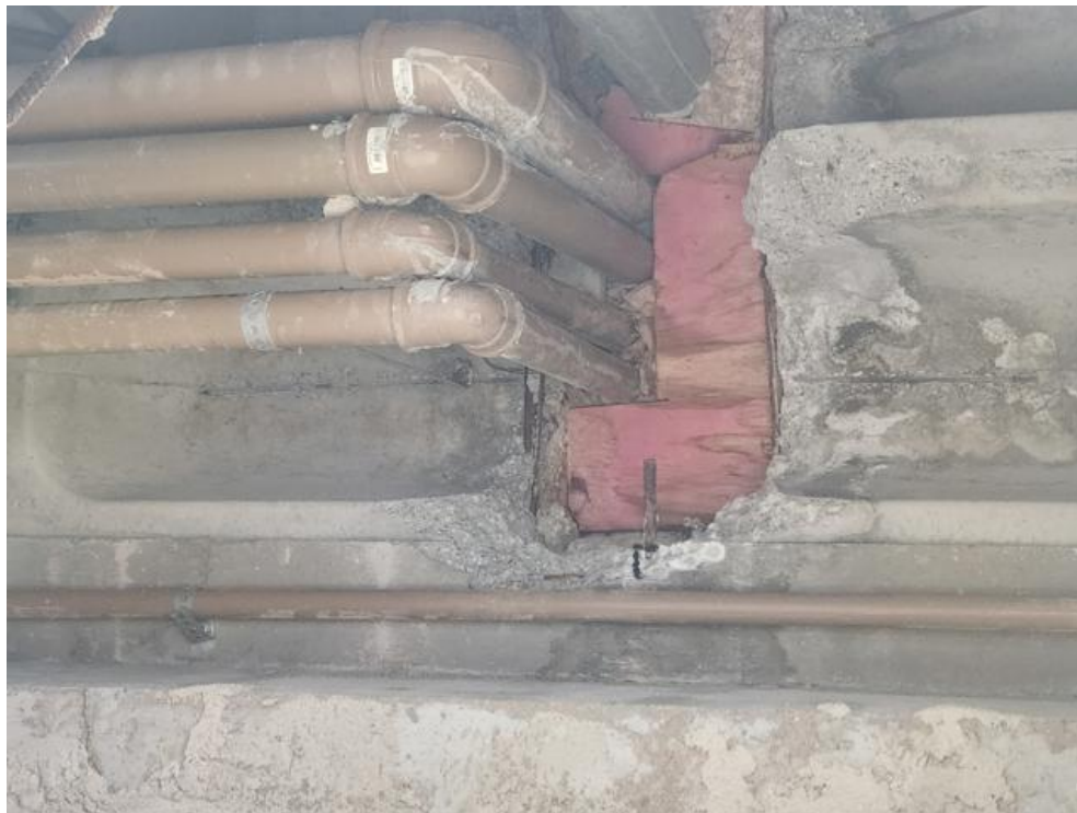
Imagem 76 - Descida de água com marcas de infiltração ao redor.
