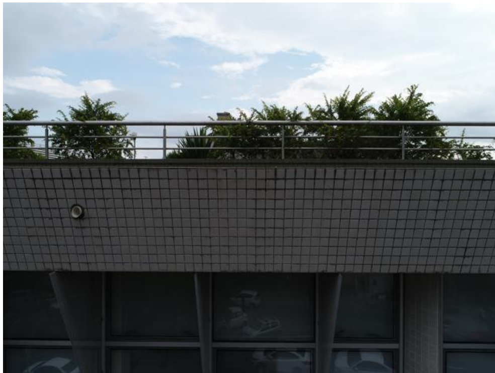
Imagem 174 - presença de vegetação e sujidade, ausência de rejuntas e pingadeiras.
