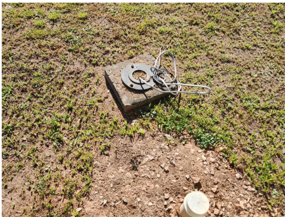
Imagem 21 – Suporte para fixação de iluminação externa
