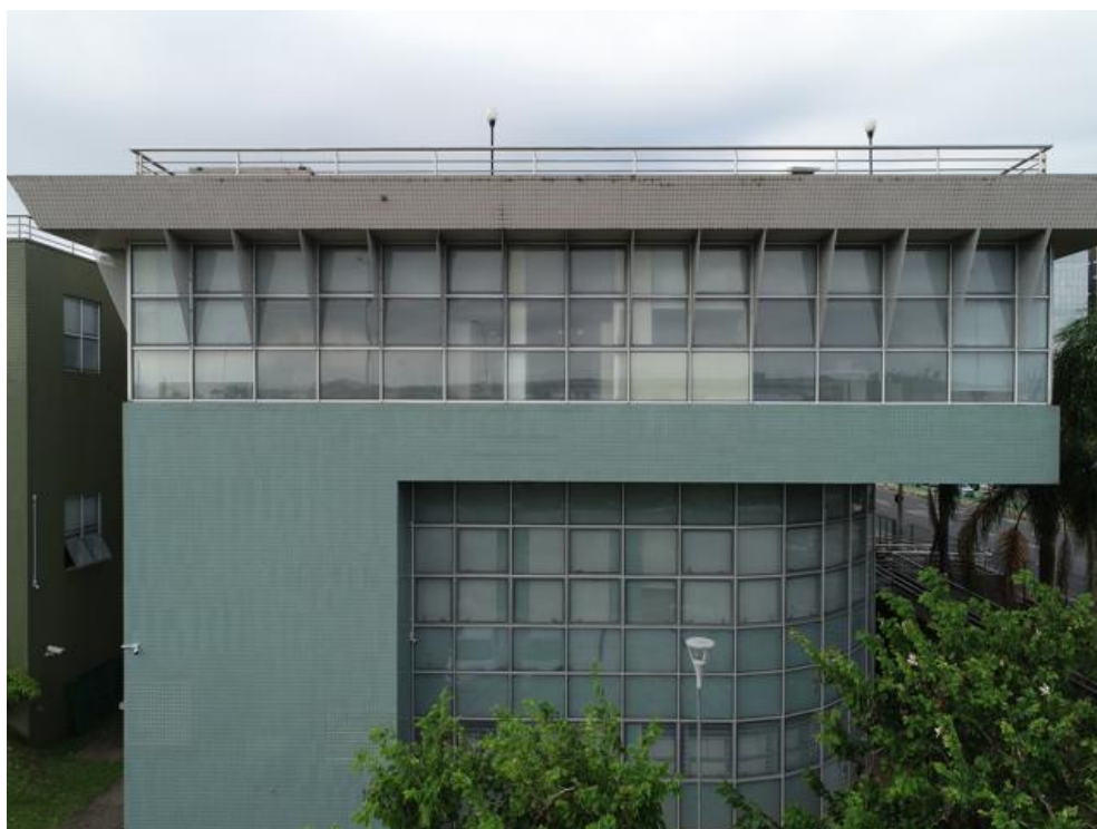
Imagem 241 - Presença de sujeira, vegetação, ausência de rejuntas e pingadeiras – Trecho com pastilhas verde claro em bom estado.
