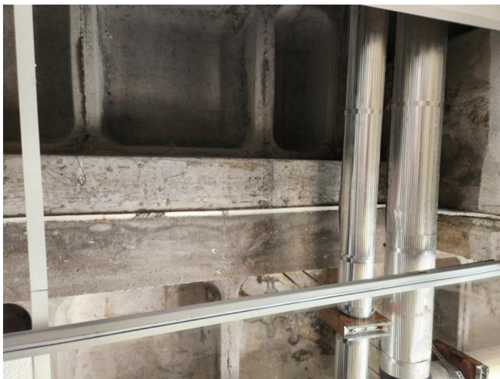
Imagem 73 – Junta de construção, marcas de infiltração próximas da junta.
