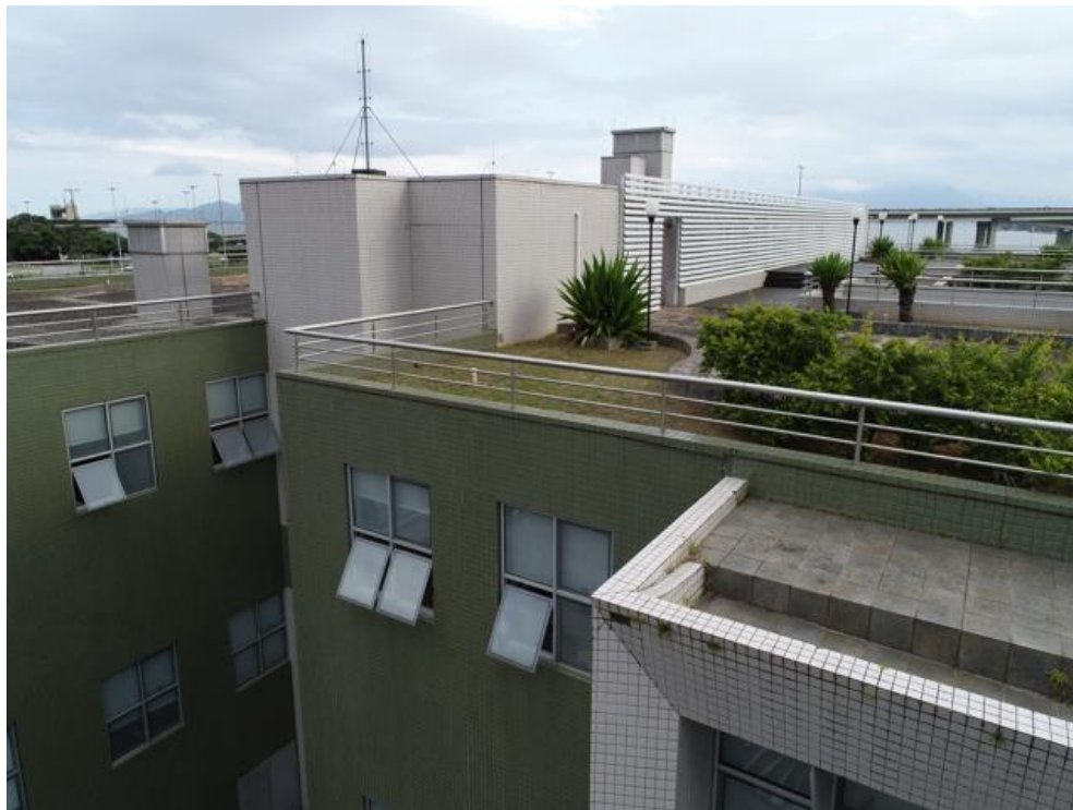
Imagem 178 – Lacunas nas pastilhas, presença de sujeira, vegetação e ausência das pingadeiras e rejuntas.
