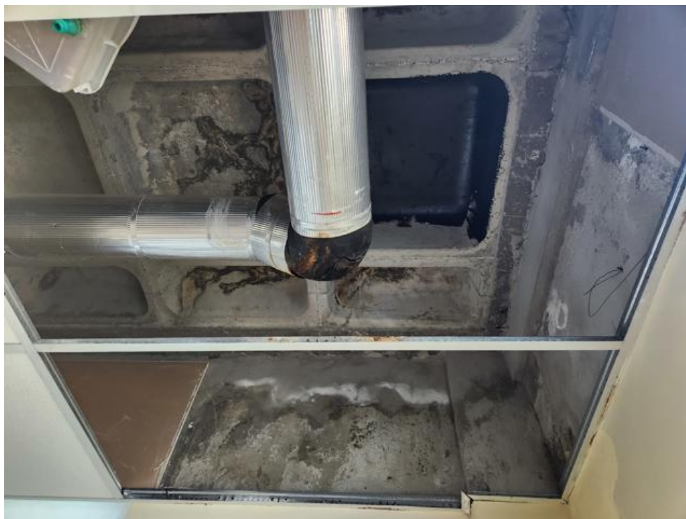
Imagem 79 – Marcas severas de infiltração.
