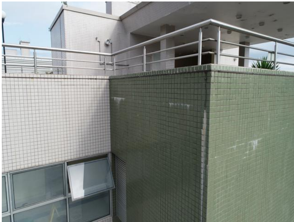
Imagem 188 - Fixação do SPDA inadequada na parede.
