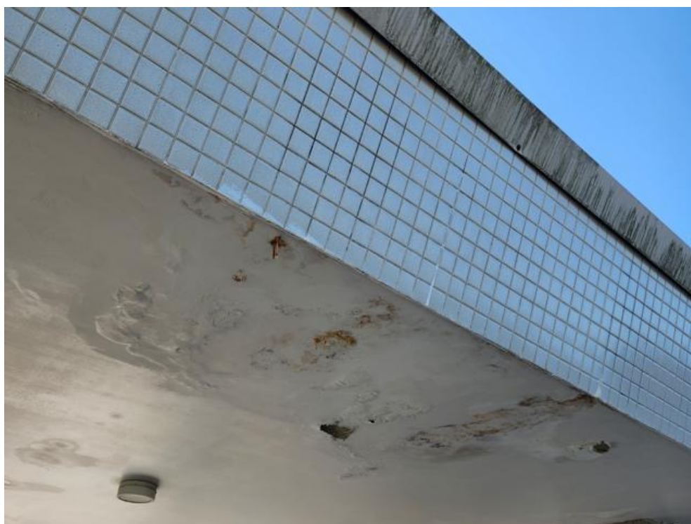
Imagem 31 – Processo de infiltração e carbonatação do concreto e corrosão das armaduras. – Setor ciano.
