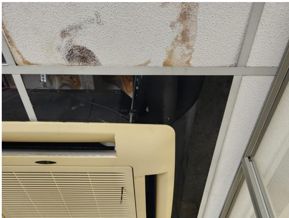
Imagem 91 - Marcas severas de infiltração na laje, danos nas placas de forro mineral, risco de danos em equipamentos.
