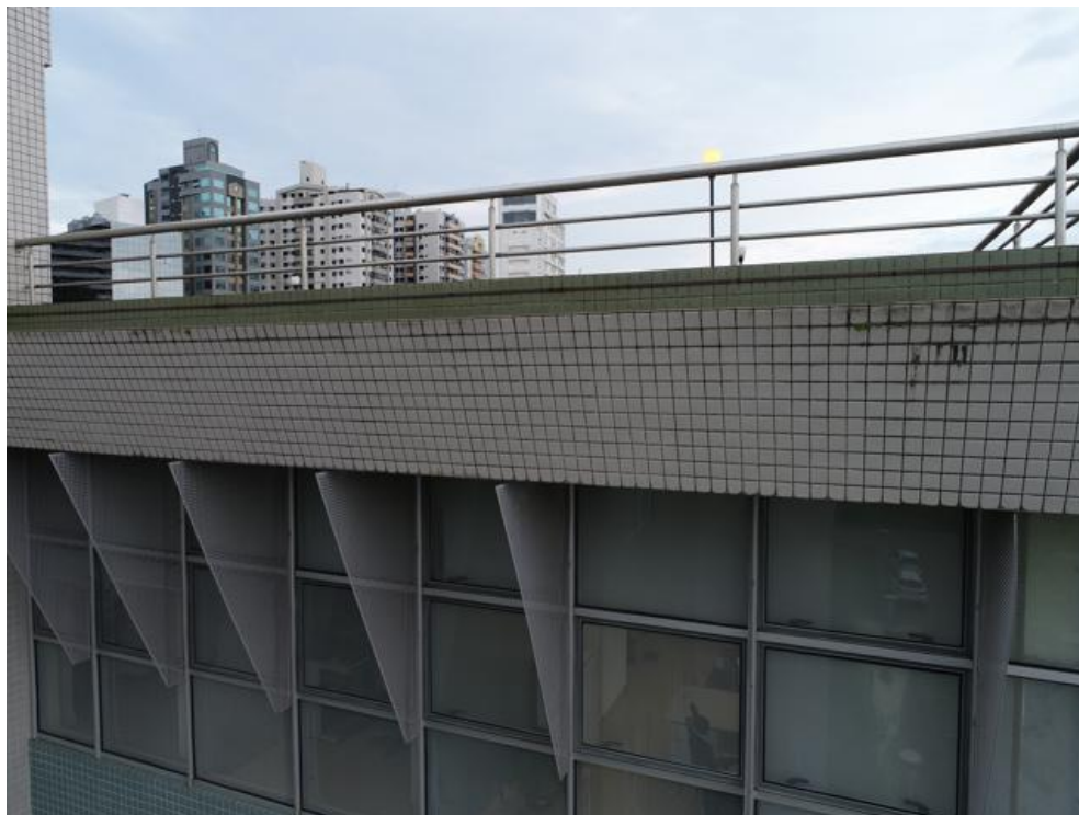
Imagem 232 – Presença de sujeira, vegetação, ausência de rejuntas e pingadeiras.
