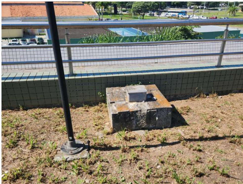
Imagem 46 – Caixa de passagem – Setor verde – Revestimento inadequado.
