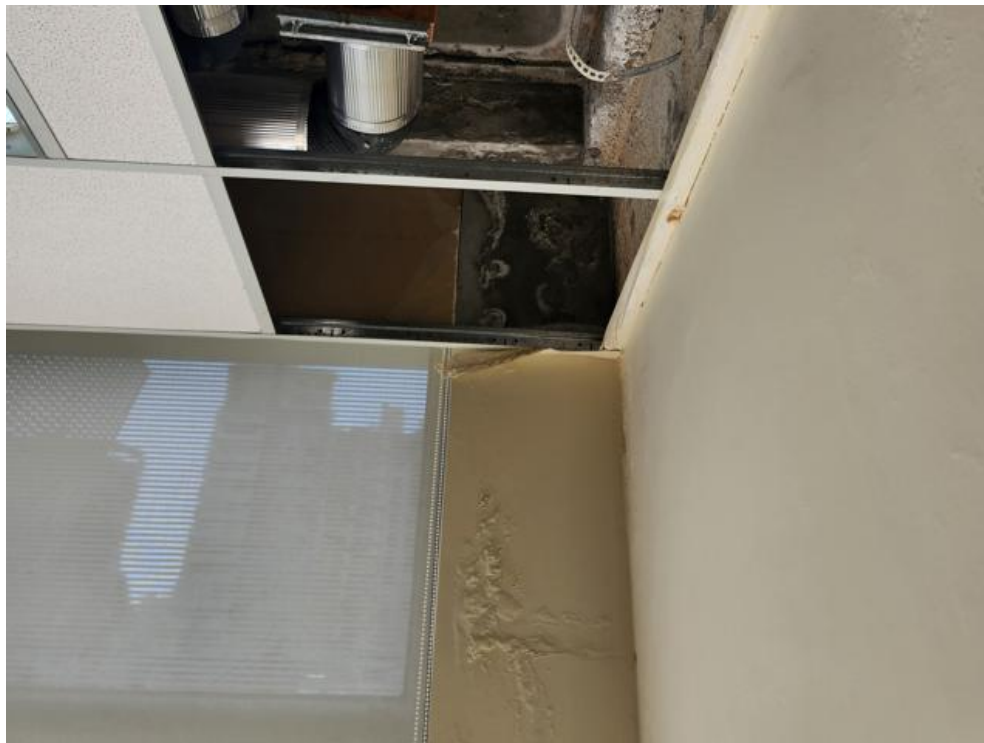
Imagem 70 – Infiltração atingindo o revestimento das paredes.
