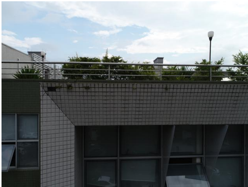
Imagem 172 – Lacunas nas pastilhas, presença de vegetação e sujeira, ausência de rejuntas e pingadeiras
